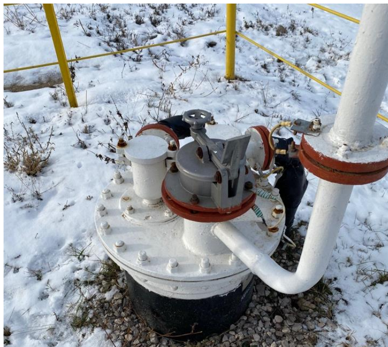
Рисунок 2 – Общий вид резервуара РГС-5
