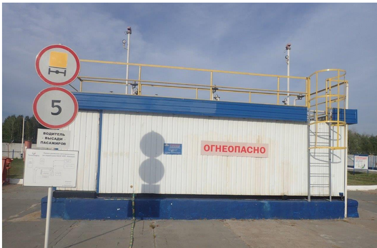
Рисунок 2 – Общий вид резервуаров РГС-10
