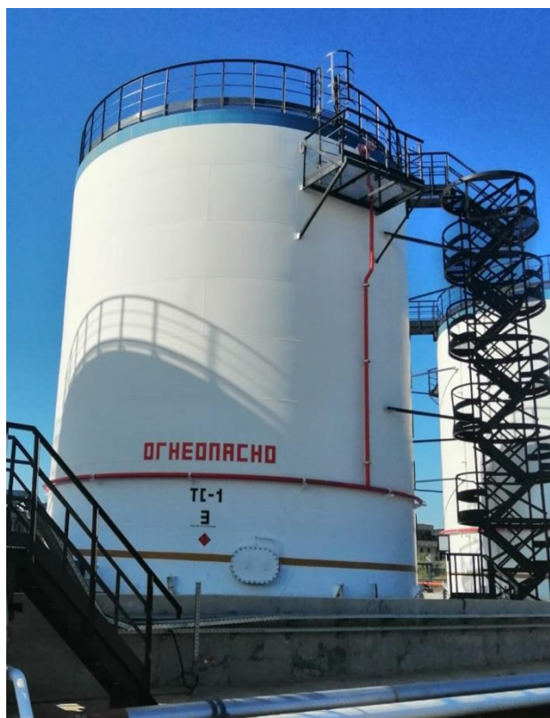
Рисунок 2 – Общий вид резервуаров РВС-1025
