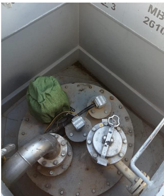
Рисунок 7 – Общий вид резервуаров РГС-50 зав.№№ 2892, 2893
