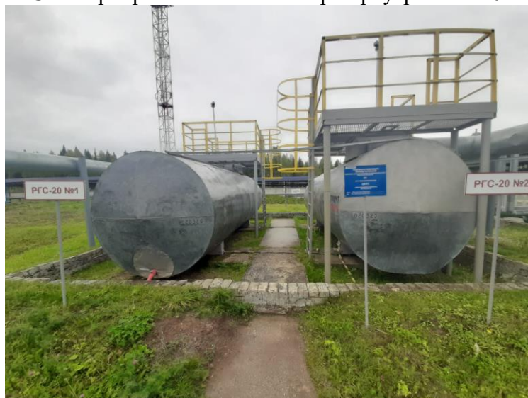
Рисунок 20 – Общий вид резервуаров РГС-20 зав.№№ 710, 711
