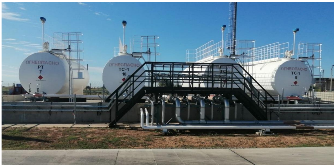
Рисунок 1 – Общий вид резервуаров РГС-50 зав.№№ 2895, 2896, 2897, 2898
