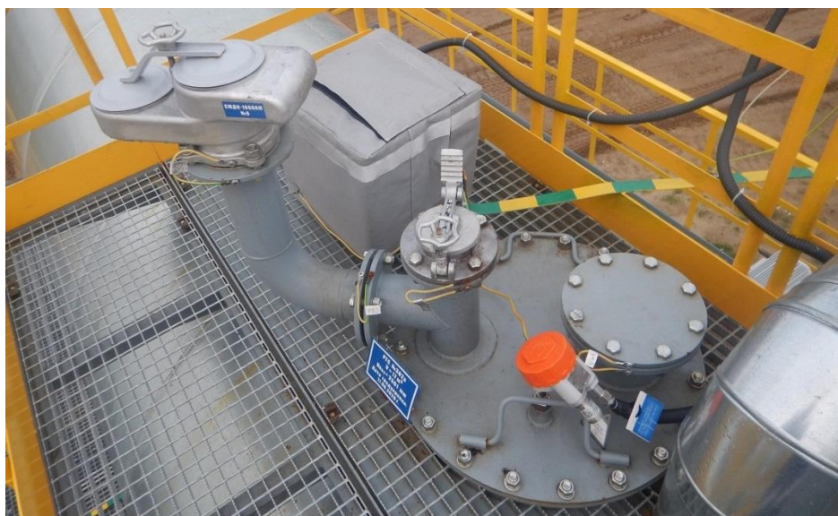
Рисунок 10 – Общий вид резервуаров РГС-20 зав.№№ 382, 383
