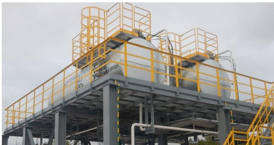
Рисунок 9 – Общий вид резервуаров РГС-20 зав.№№ 382, 383
