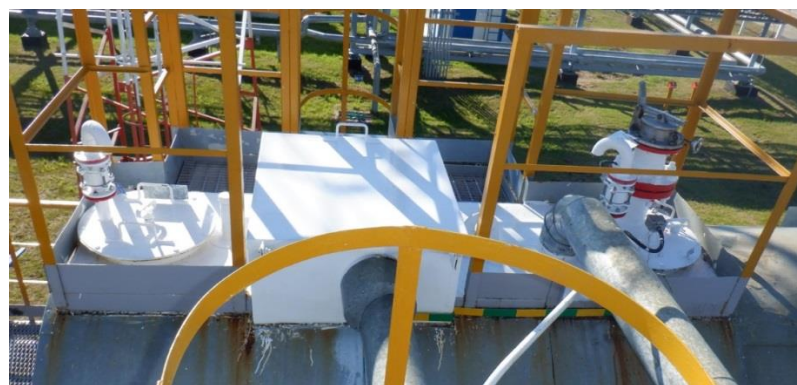
Рисунок 2 – Общий вид резервуаров РГС-20 зав.№№ 107, 108
