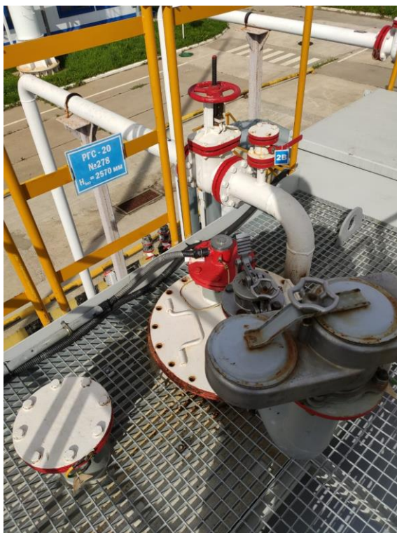
Рисунок 14 – Общий вид резервуаров РГС-20 зав.№№ 278, 279
