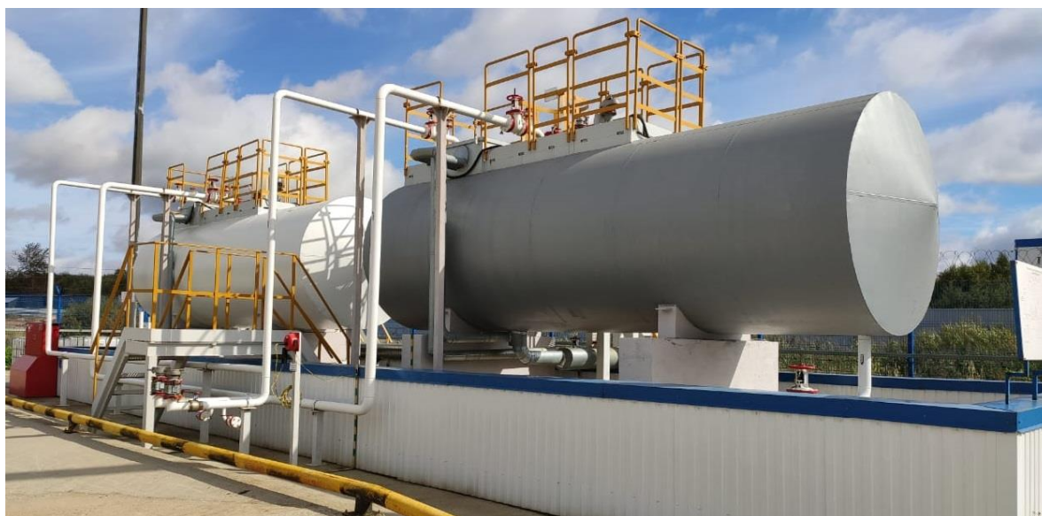
Рисунок 13 – Общий вид резервуаров РГС-20 зав.№№ 278, 279
