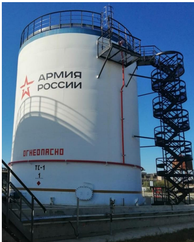
Рисунок 1 – Общий вид резервуаров РВС-1025
