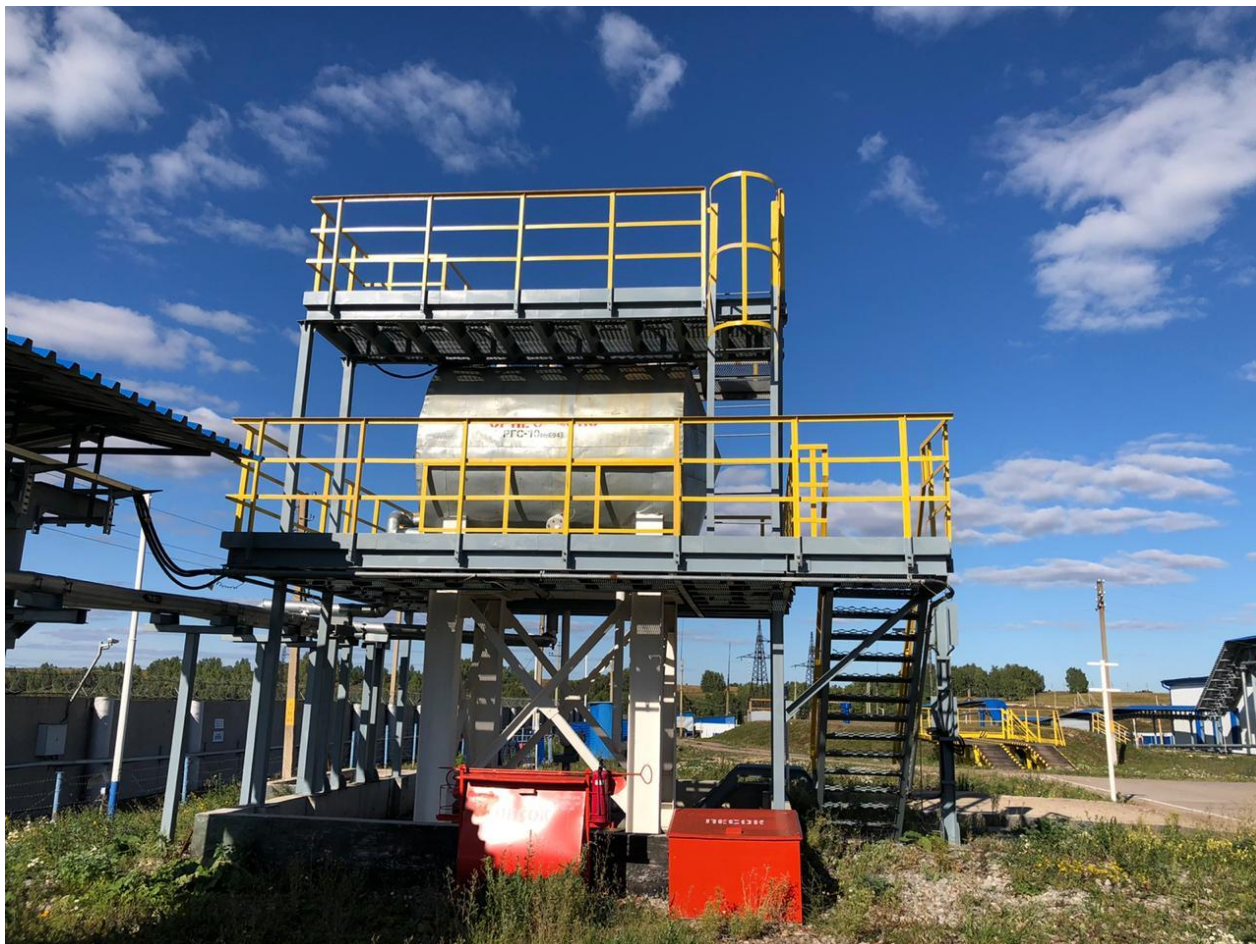
Рисунок 2 – Общий вид резервуара РГС-10
