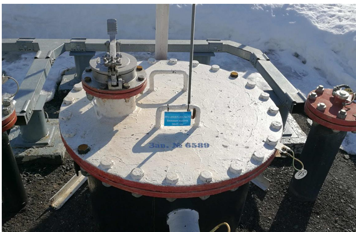
Рисунок 2 – Общий вид резервуара РГС-20 с заводским номером 6589
