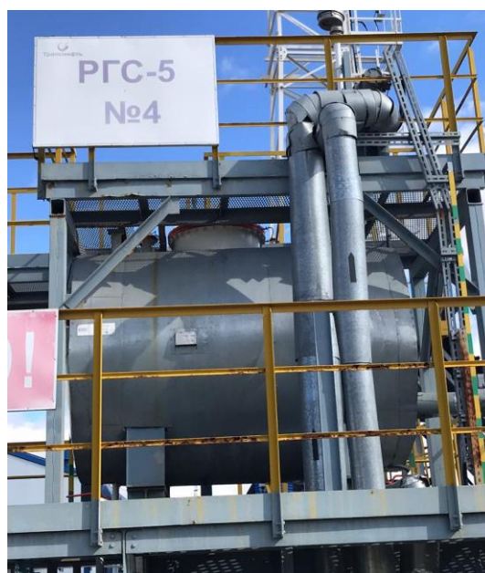
Рисунок 3 – Общий вид резервуара РГС-5 с заводским номером 58555
