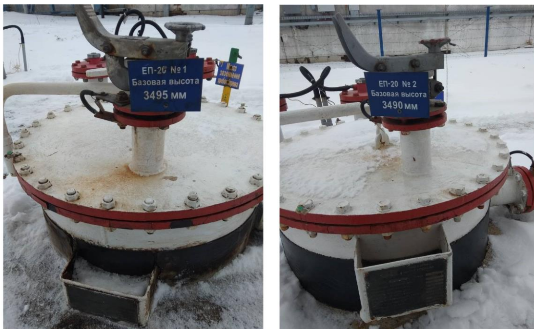
Рисунок 2 – Общий вид резервуаров РГС-20
