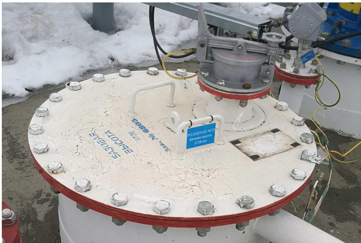
Рисунок 1 – Общий вид резервуара РГС-20 с заводским номером 6805
