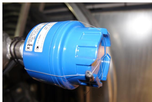
Рисунок 13 – Пломбирование датчика температуры
