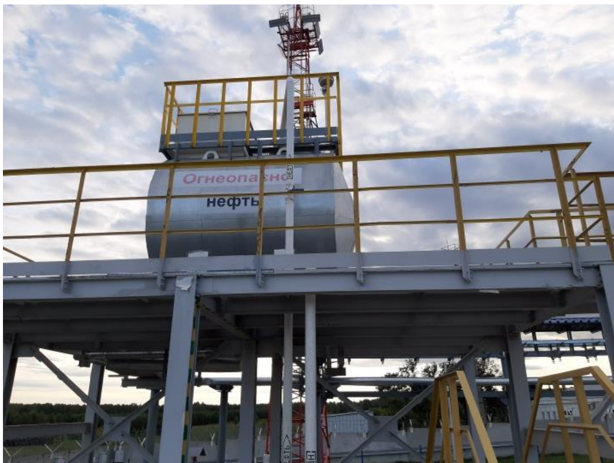
Рисунок 2 – Общий вид резервуара РГС-10
