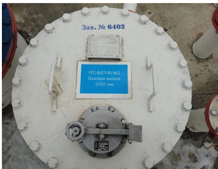
Рисунок 2 – Общий вид резервуара РГС-8 с заводским номером 6402
