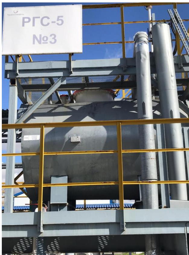
Рисунок 2 – Общий вид резервуара РГС-5 с заводским номером 58554
