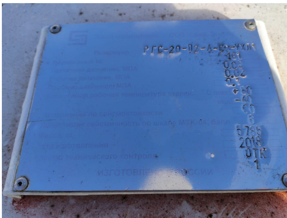
Рисунок 7 – Маркировочная табличка резервуара РГС-20 зав.№ 161
