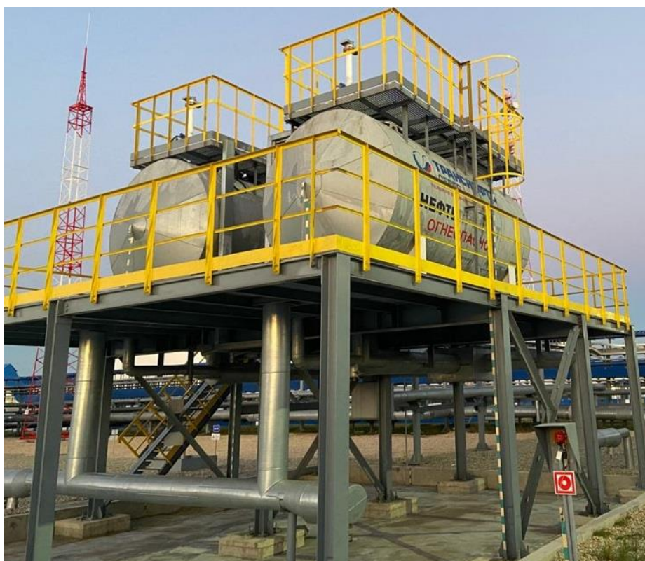
Рисунок 1 – Общий вид резервуаров РГС-20 зав.№ 90, 91
