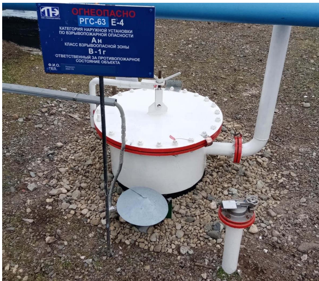
Рисунок 2 – Общий вид резервуаров РГС-63
