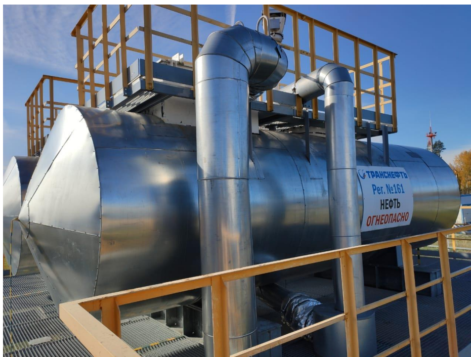
Рисунок 6 – Общий вид резервуара РГС-20 зав.№ 161
