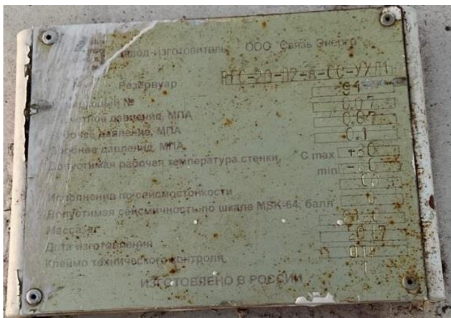
Рисунок 3 – Маркировочная табличка резервуара РГС-20 зав.№ 91
