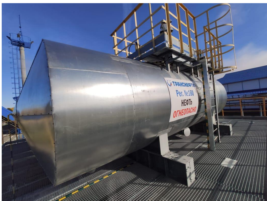
Рисунок 4 – Общий вид резервуара РГС-20 зав.№ 160
