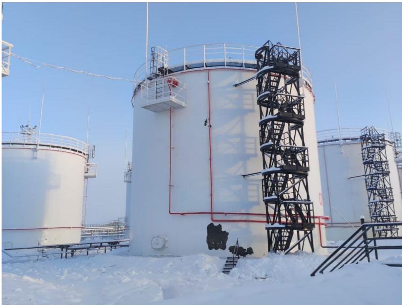
Рисунок 1 – Общий вид резервуаров РВС-2000
