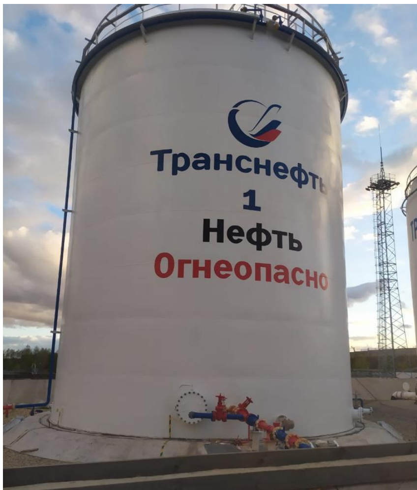
Рисунок 1 – Общий вид резервуара РВС-1000
