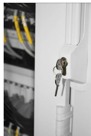
Рисунок 17 – Замок передней двери стойки приборной
