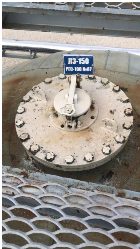
Рисунок 2 – Общий вид резервуара РГС-100 зав.№ 87
