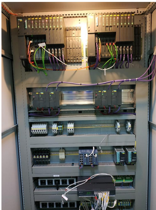
Рисунок 2 – Общий вид среднего уровня (контроллеры CPU 417-4 H Primary)
