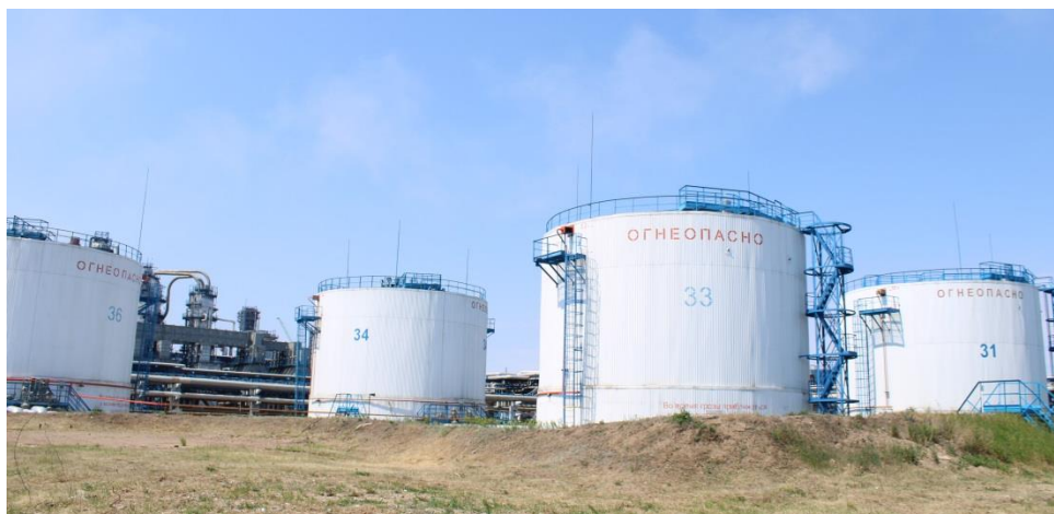
Рисунок 1 – Общий вид резервуаров стальных вертикальных цилиндрических РВС-2000
