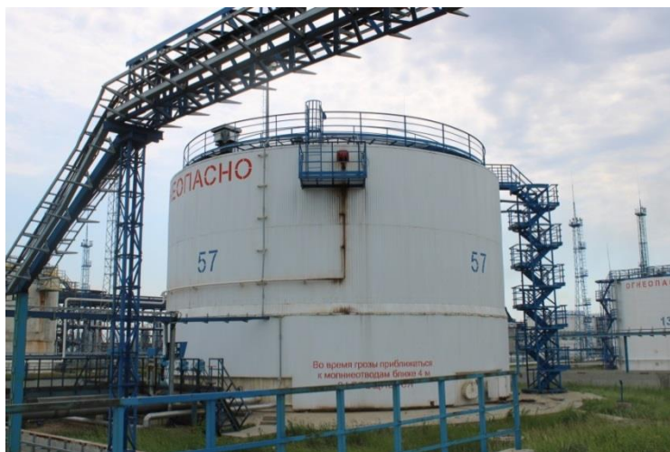
Рисунок 1 – Общий вид резервуара стального вертикального цилиндрического РВС-3000
