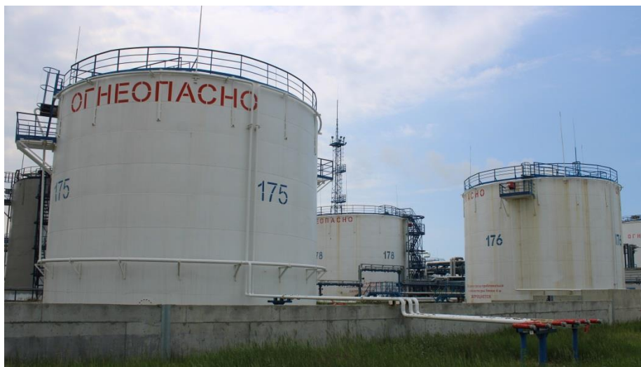
Рисунок 1 – Общий вид резервуаров стальных вертикальных цилиндрических РВС-2000
