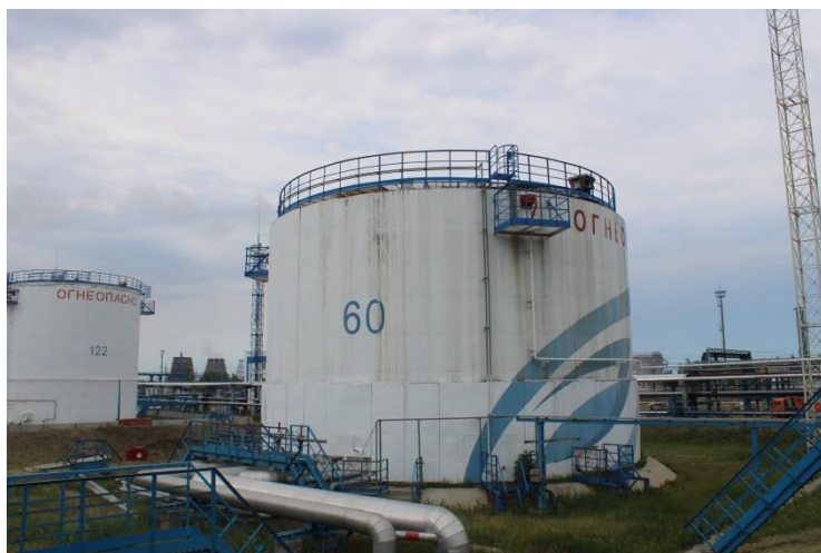
Рисунок 1 – Общий вид резервуара стального вертикального цилиндрического РВС-3000.
