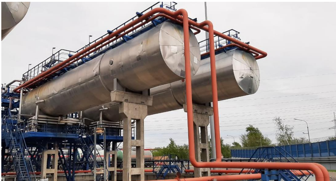
Рисунок 2 – Общий вид резервуаров РГС-200
