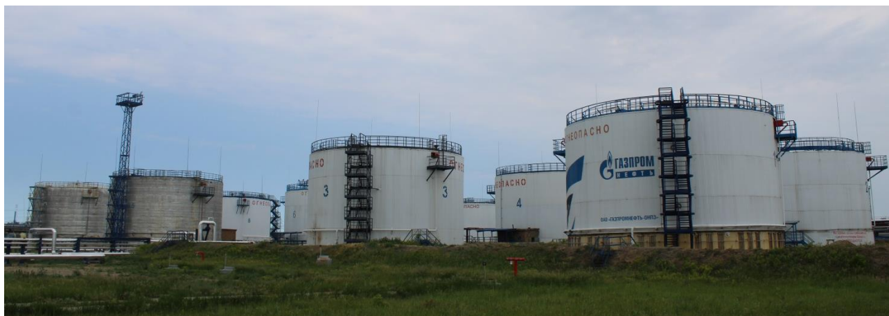
Рисунок 1 – Общий вид резервуаров стальных вертикальных цилиндрических РВС-3000
