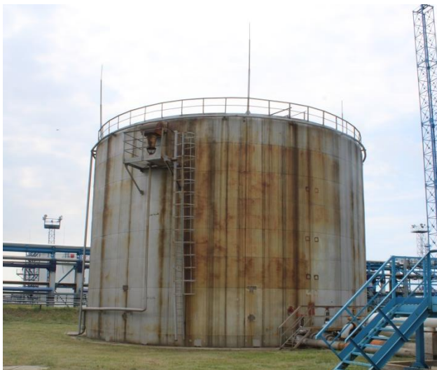
Рисунок 1 – Общий вид резервуара стального вертикального цилиндрического РВС-2000
