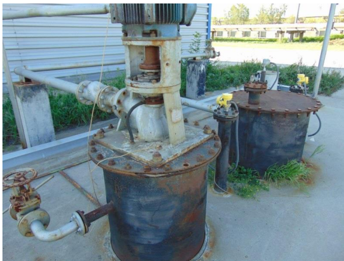
Рисунок 2 – Горловины и замерные люки резервуара стального горизонтального цилиндрического РГС-12,5
