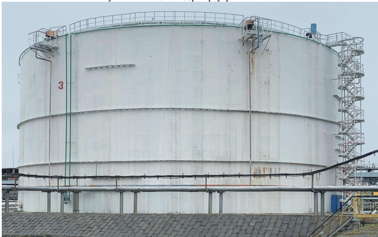
Рисунок 2 – Общий вид резервуаров РВС-20000
