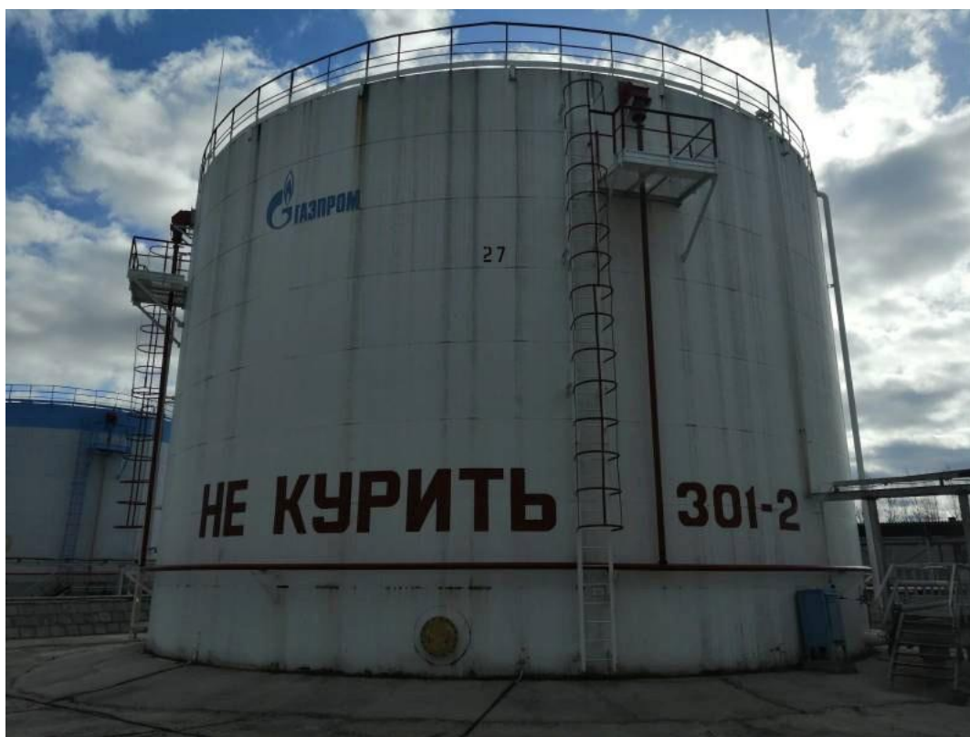
Рисунок 2 – Общий вид резервуаров РВС-3000
