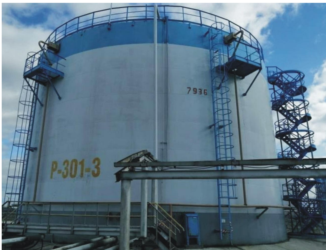
Рисунок 3 – Общий вид резервуаров РВС-3000
