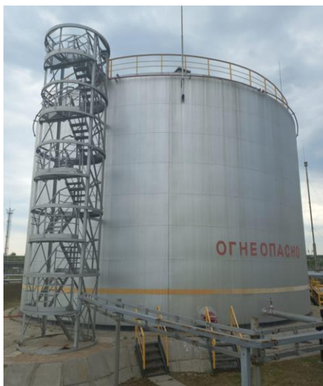
Рисунок 1 – Общий вид резервуаров стальных вертикальных цилиндрических РВС-3000
