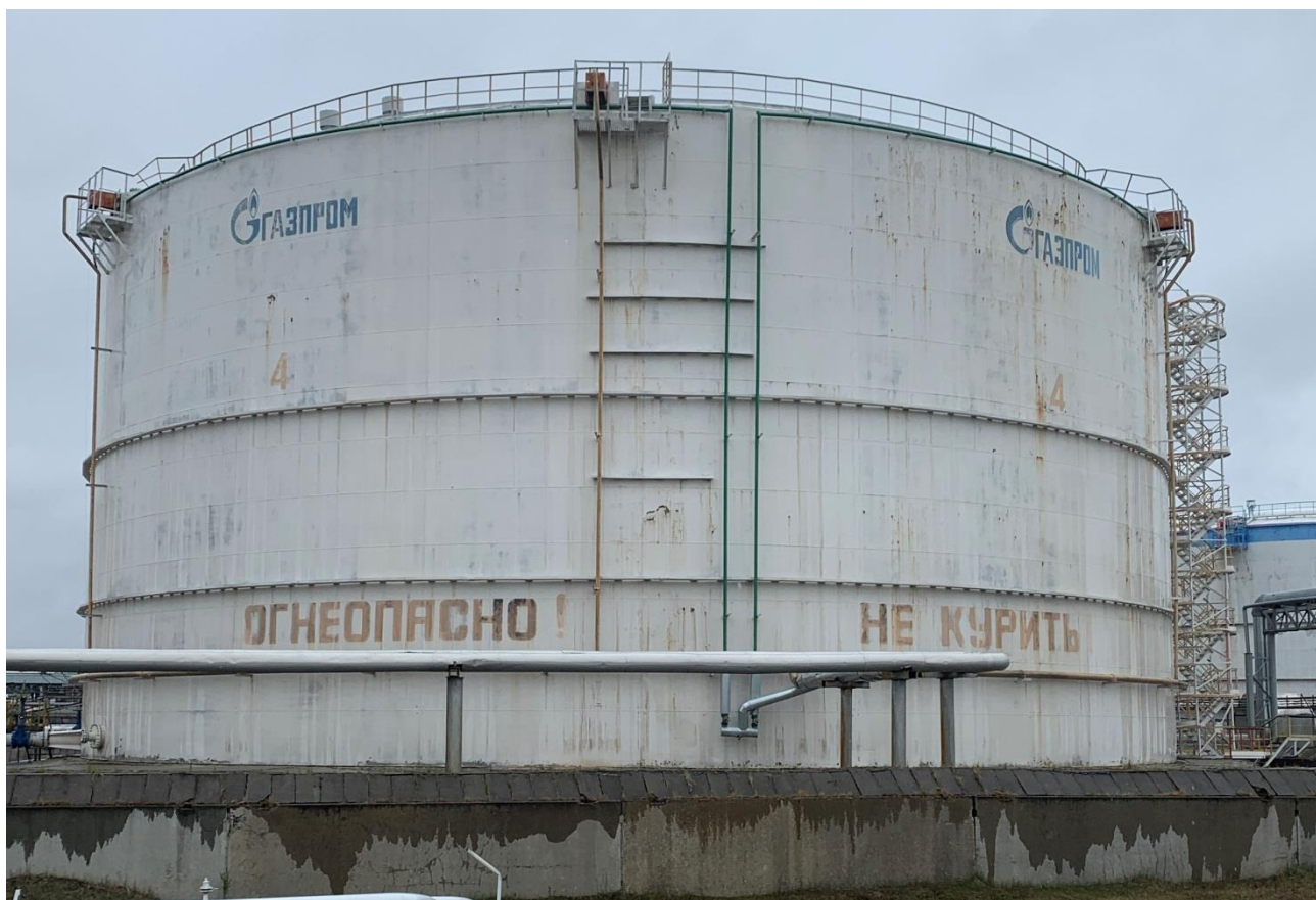
Рисунок 4 – Общий вид резервуаров РВС-20000
