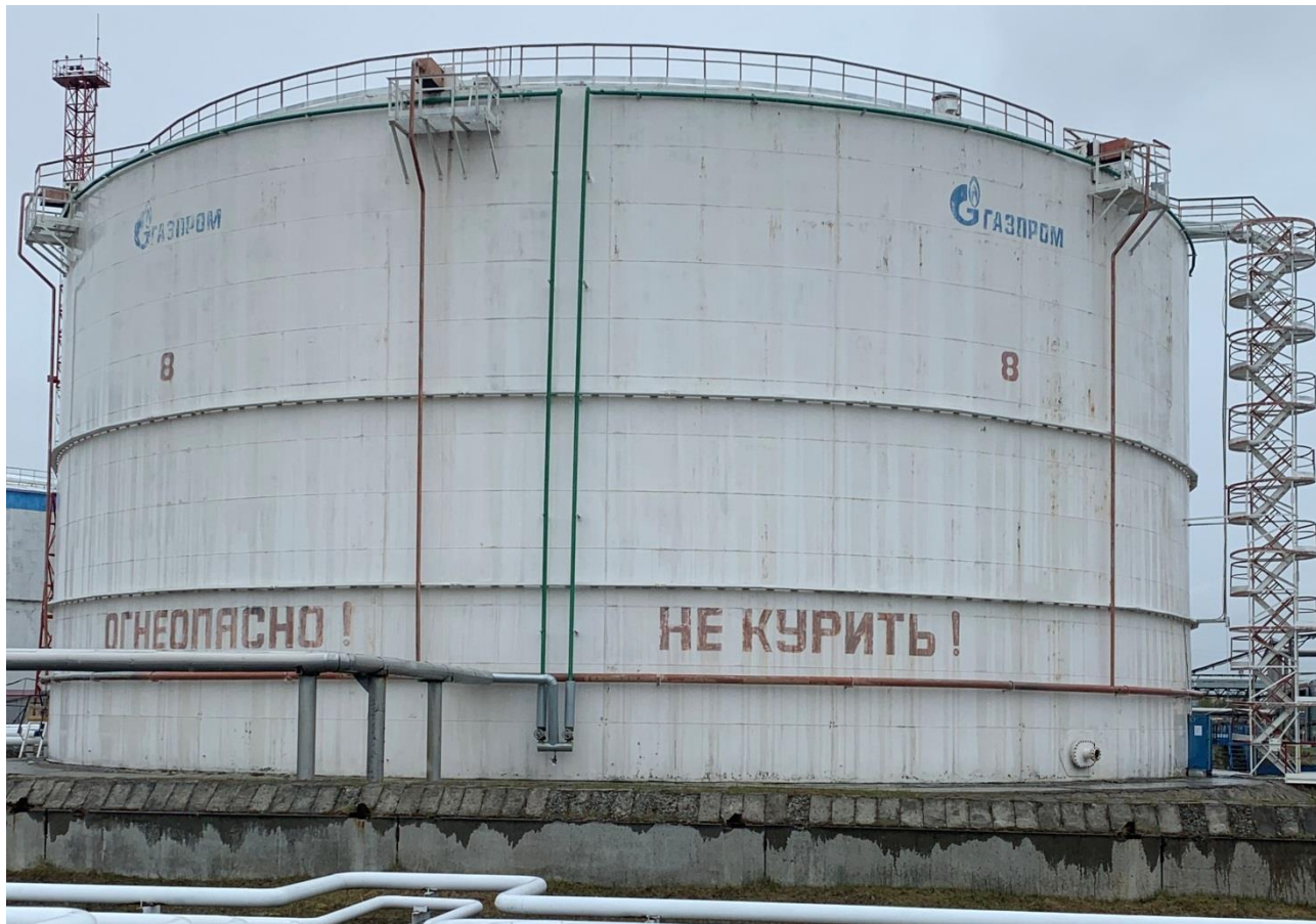
Рисунок 8 – Общий вид резервуаров РВС-20000
