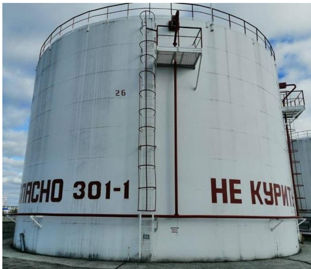
Рисунок 1 – Общий вид резервуаров РВС-3000
