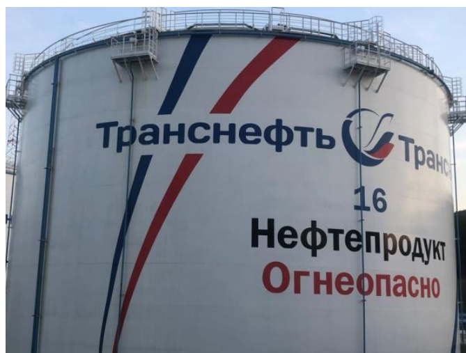
Рисунок 2 – Общий вид резервуара РВСП-20000 зав.№ 16
