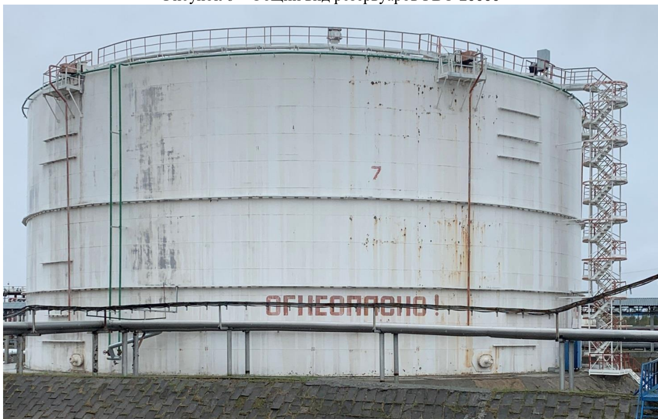
Рисунок 6 – Общий вид резервуаров РВС-20000
