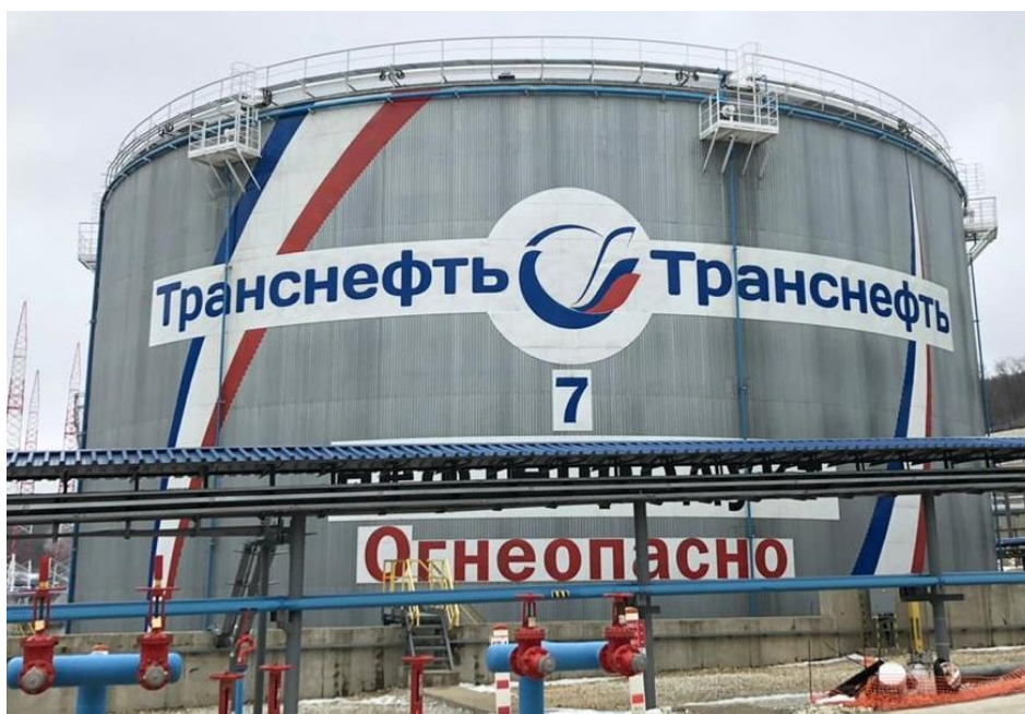
Рисунок 1 – Общий вид резервуаров РВСт-30000
