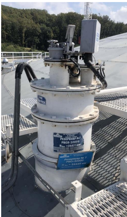
Рисунок 3 – Общий вид резервуаров РВСт-30000
