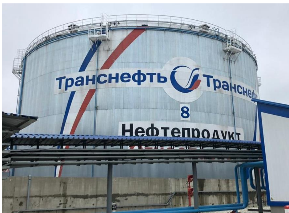
Рисунок 2 – Общий вид резервуаров РВСт-30000
