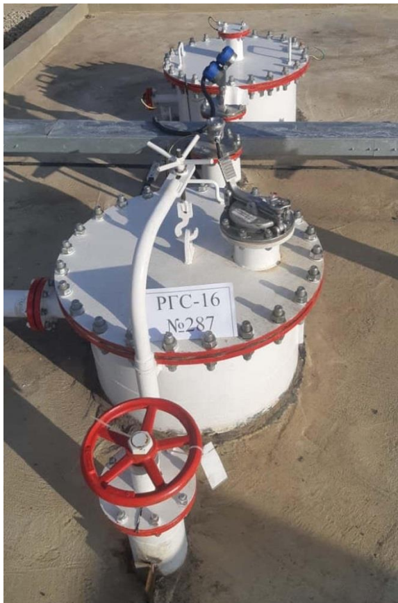
Рисунок 2 – Общий вид резервуаров РГС-16
