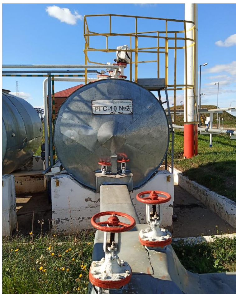
Рисунок 3 – Общий вид резервуара РГС-10 с заводским номером 2
