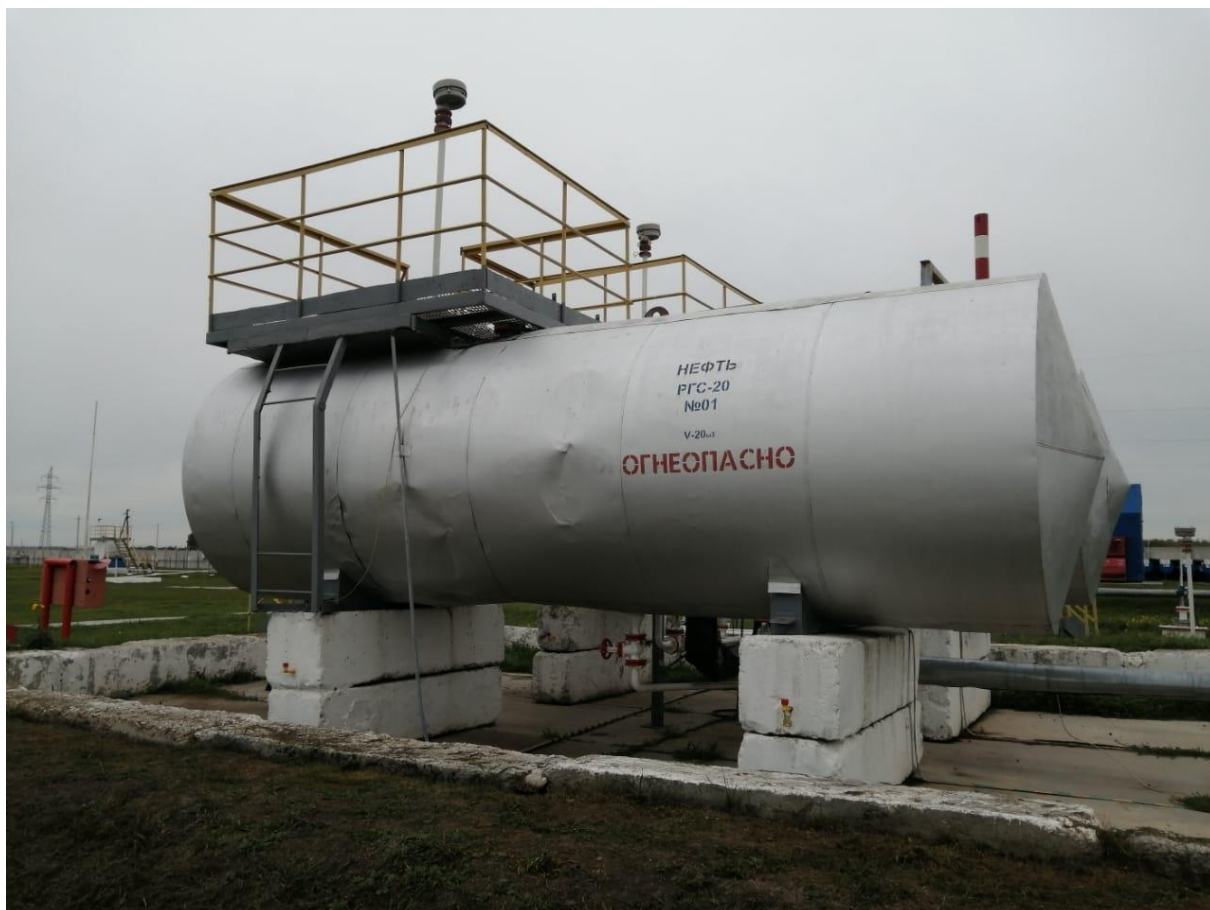
Рисунок 1 – Общий вид резервуара РГС-20 с заводским номером 1
