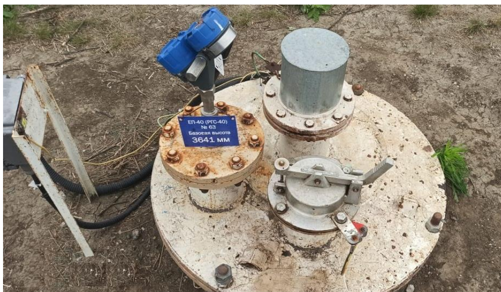
Рисунок 1 – Общий вид резервуара РГС-40
