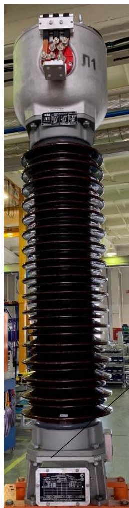
Рисунок 1 - Внешний вид трансформатора тока
