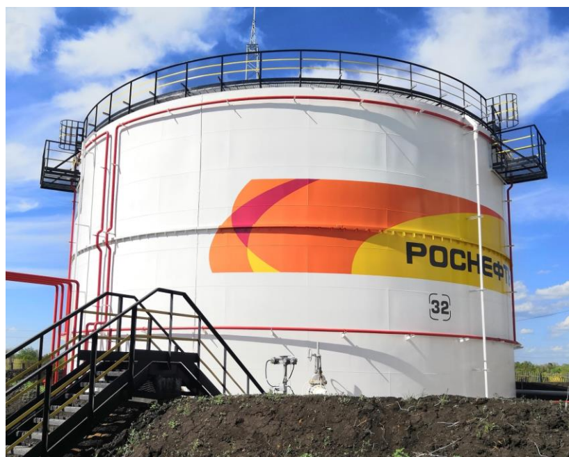
Рисунок 2 – Общий вид резервуаров РВС-5000
