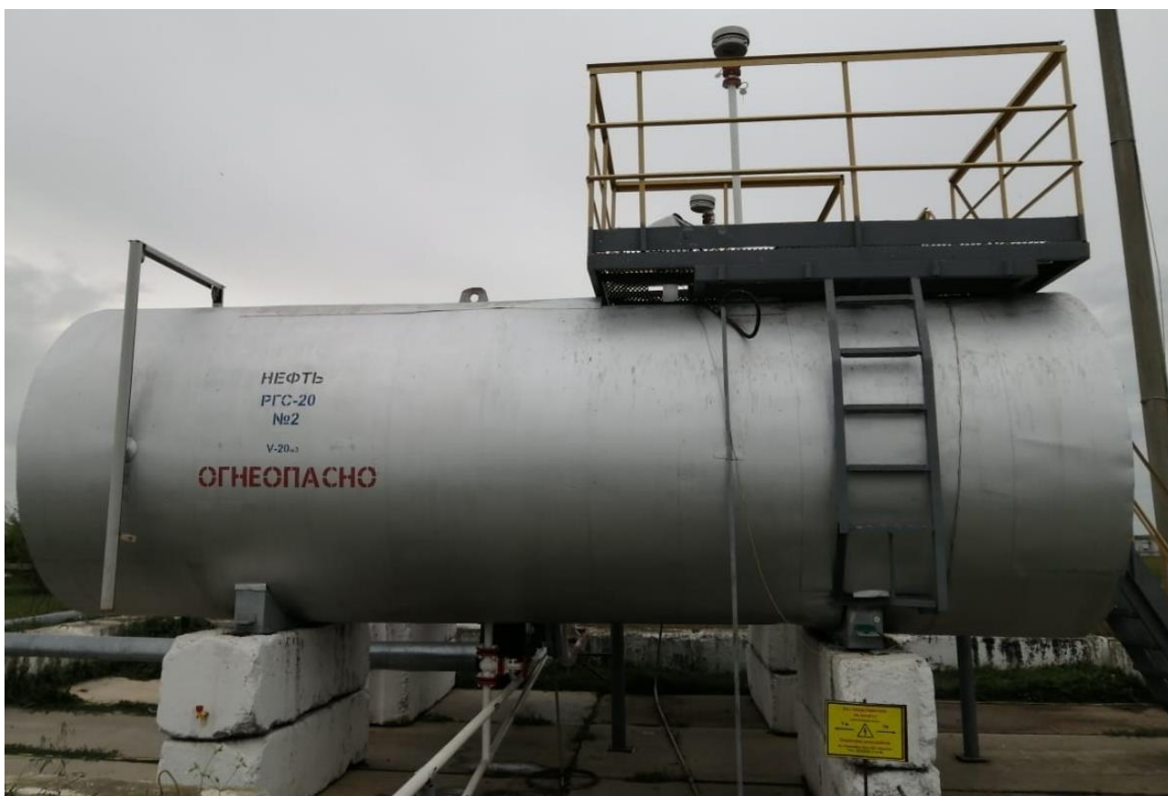
Рисунок 2 – Общий вид резервуара РГС-20 с заводским номером 2
