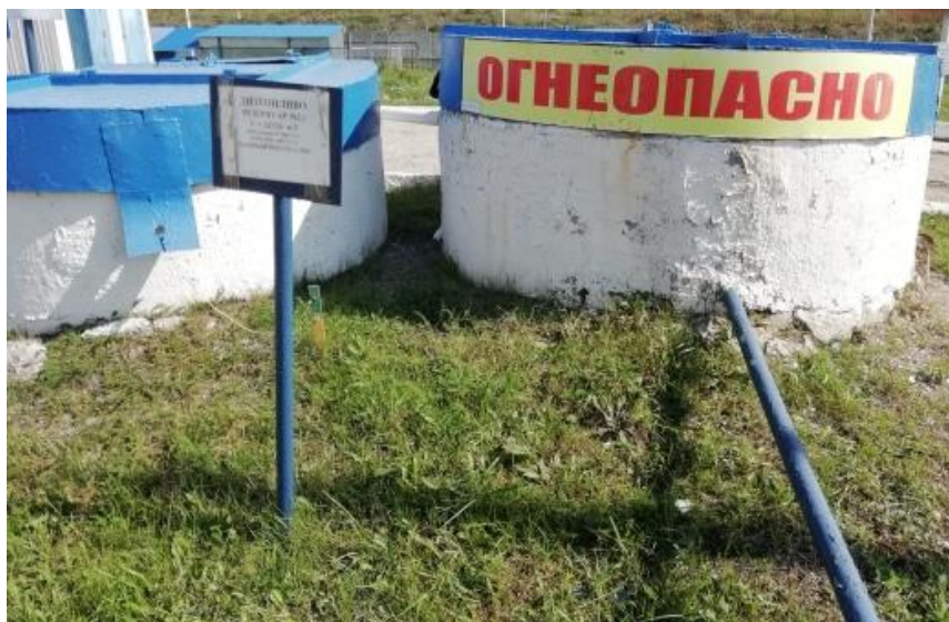
Рисунок 2 – Общий вид резервуара РГС-25
