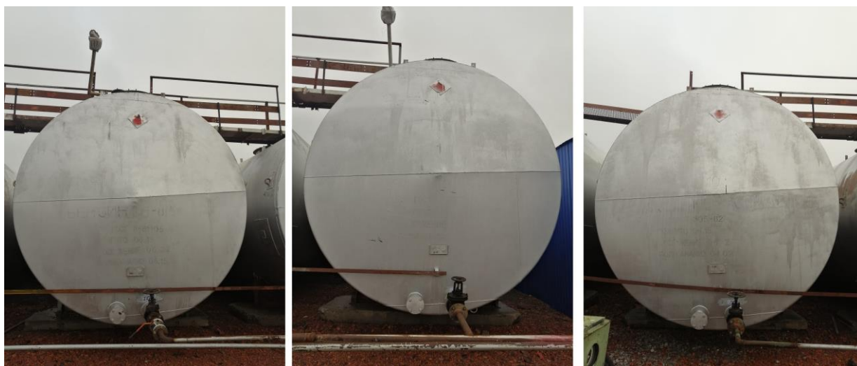
Рисунок 10 – Общий вид резервуаров Р-75Н
