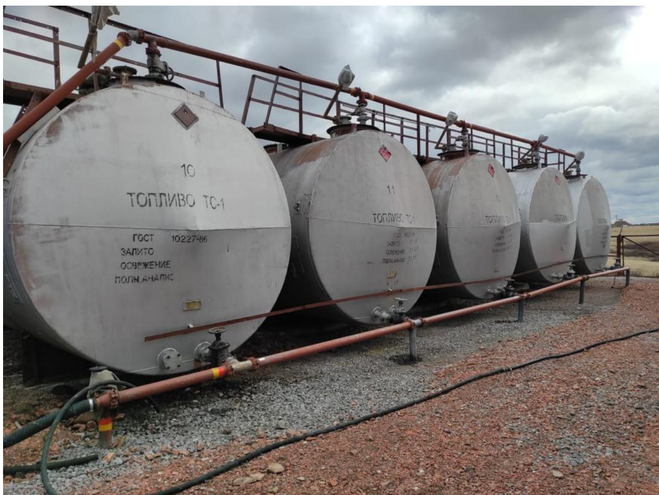
Рисунок 6 – Общий вид резервуаров Р-75Н
