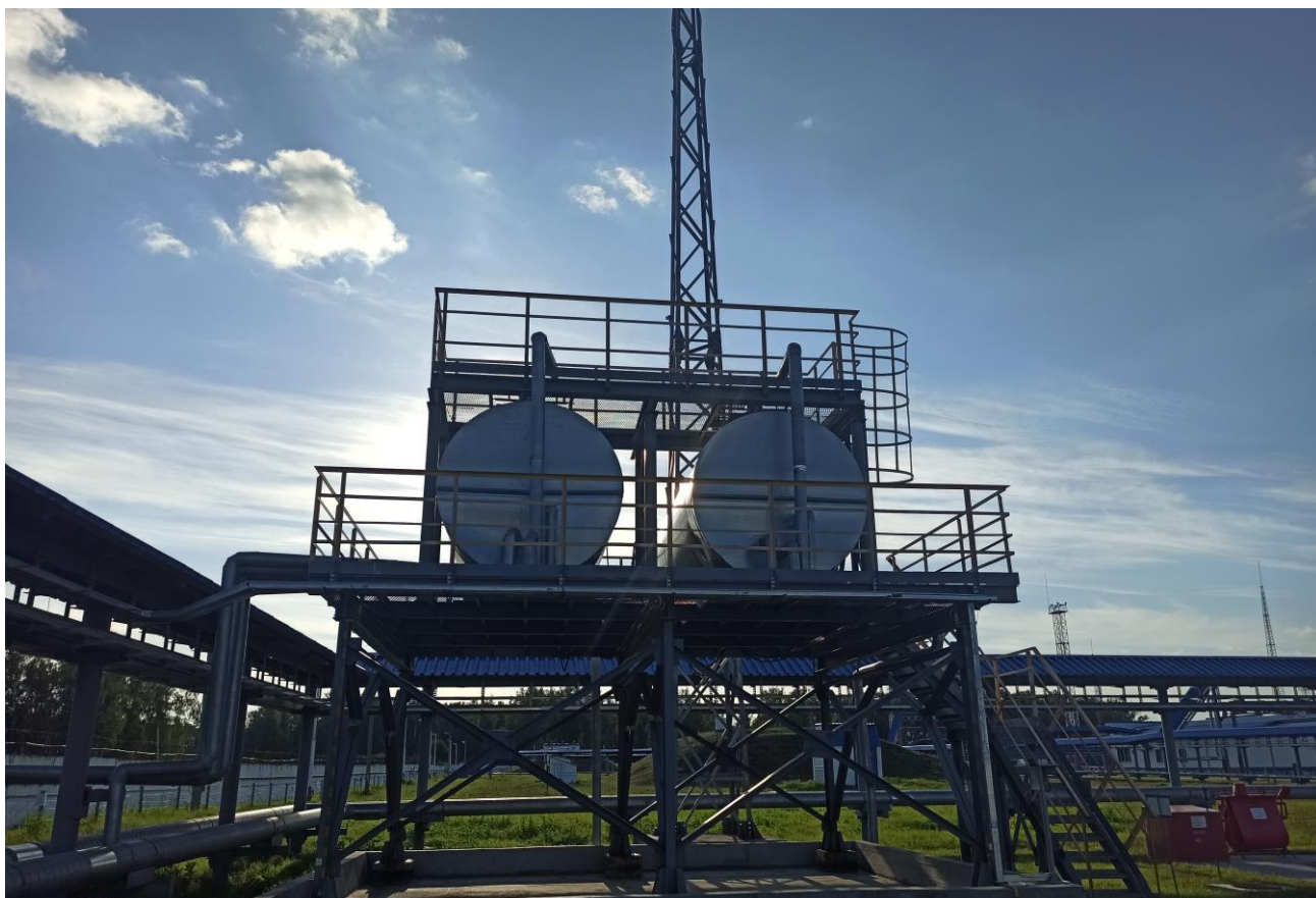
Рисунок 2 – Общий вид резервуаров РГС-10
