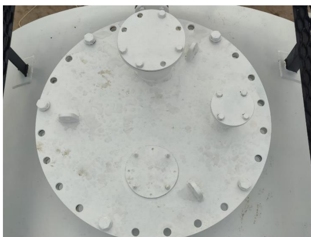
Рисунок 5 – Общий вид резервуаров РГС-50
