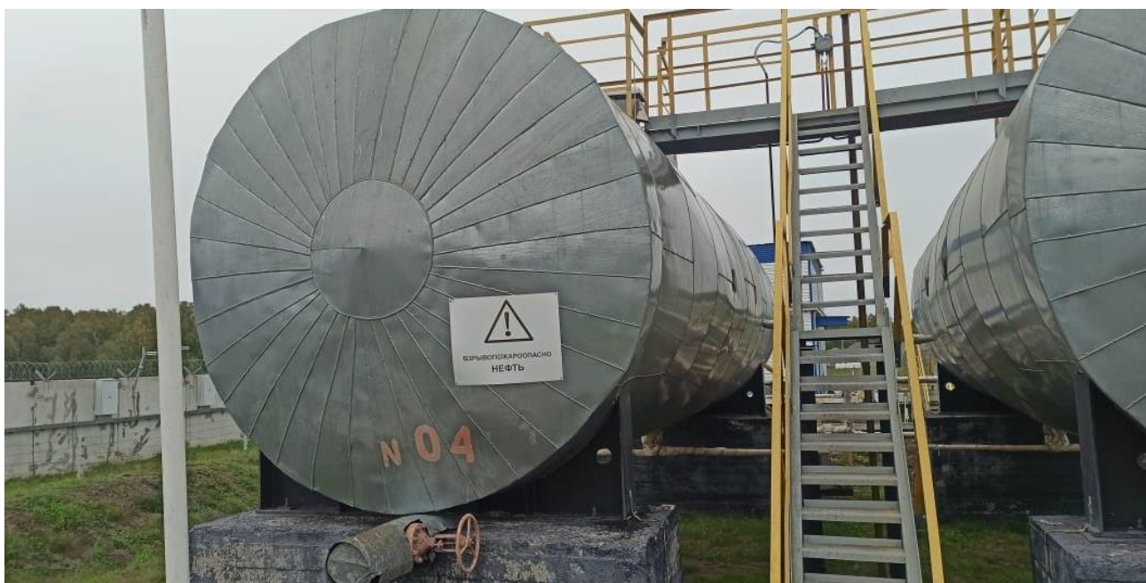
Рисунок 2 – Общий вид резервуара РГС-80 с заводским номером 04
