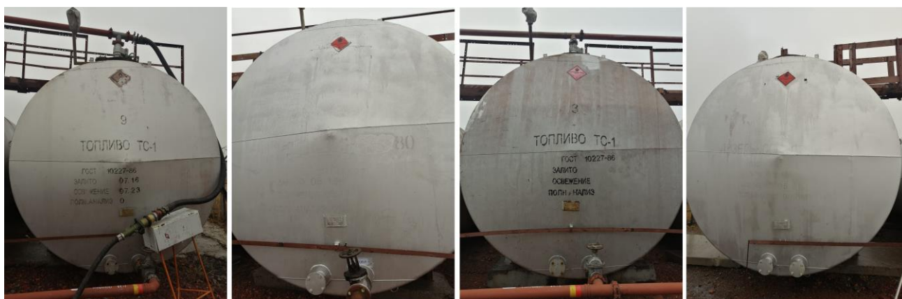
Рисунок 9 – Общий вид резервуаров Р-75Н
