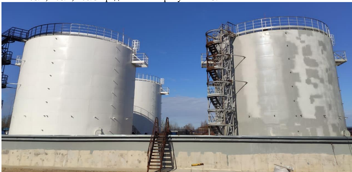
Рисунок 1 – Общий вид резервуаров РВС-2000
