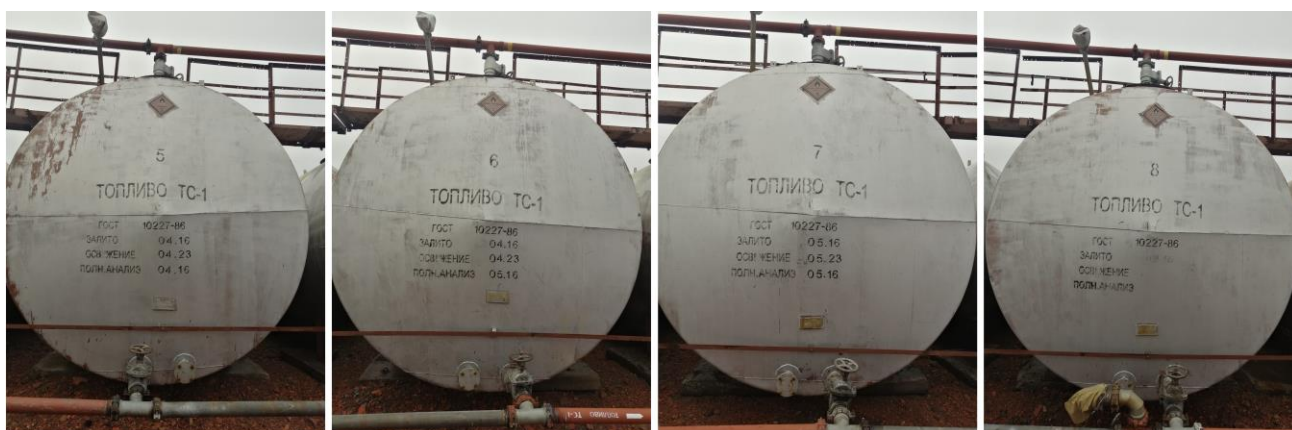
Рисунок 8 – Общий вид резервуаров Р-75Н
