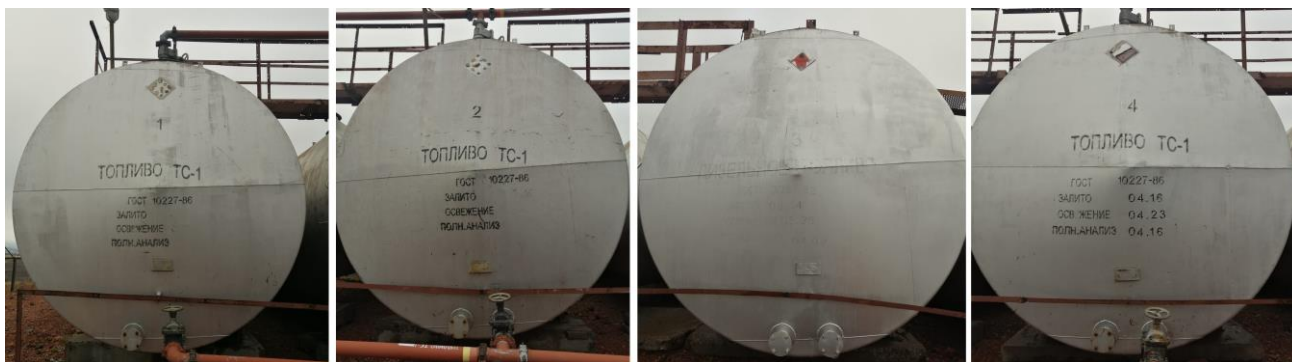
Рисунок 7 – Общий вид резервуаров Р-75Н
