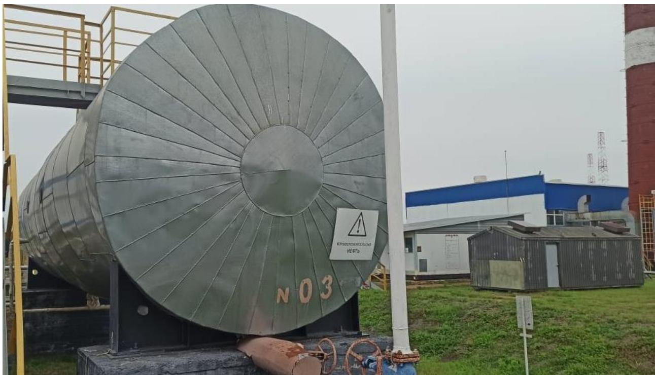
Рисунок 1 – Общий вид резервуара РГС-80 с заводским номером 03
