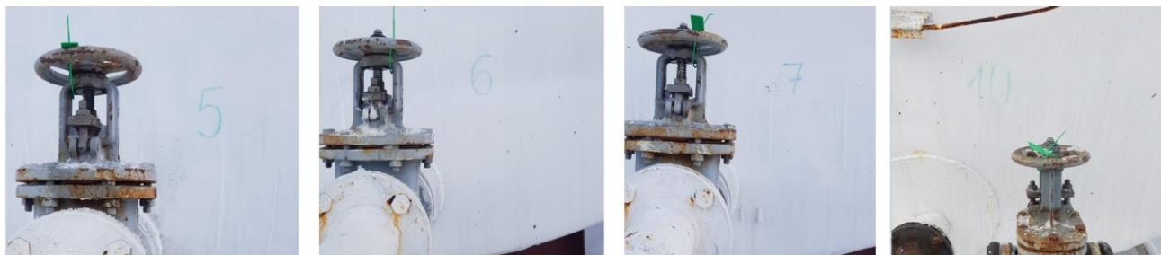
Рисунок 2 – Место и способ нанесения заводских номеров
