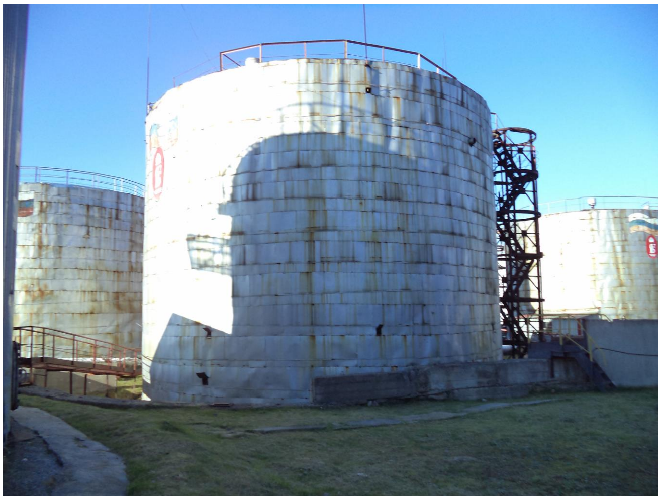
Рисунок 1 – Общий вид резервуара
