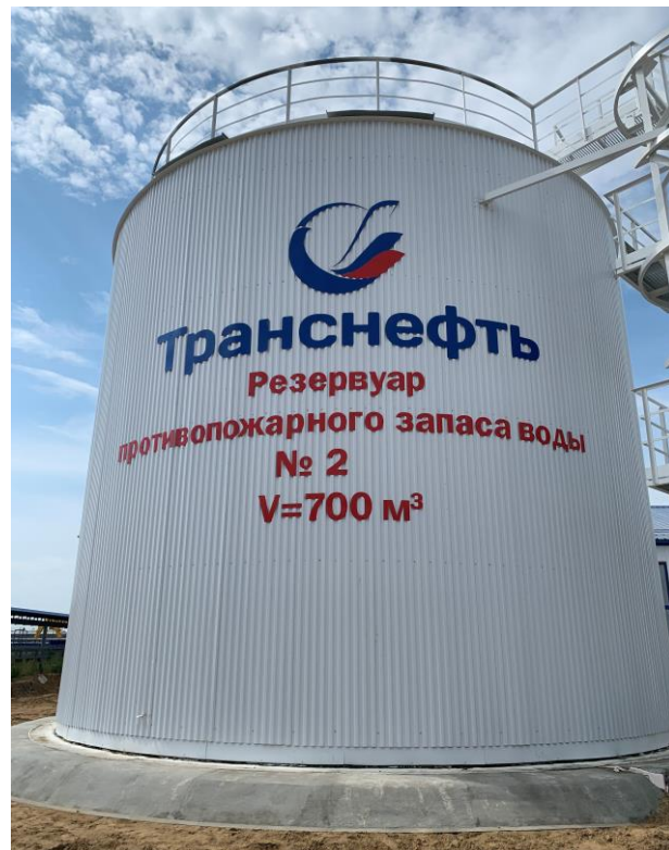
Рисунок 2 – Общий вид резервуара РВС-700 с заводским номером 352.2
