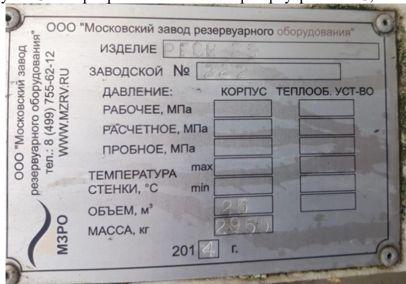
Рисунок 3 – Маркировочная табличка резервуара РГС-25, зав.№221
