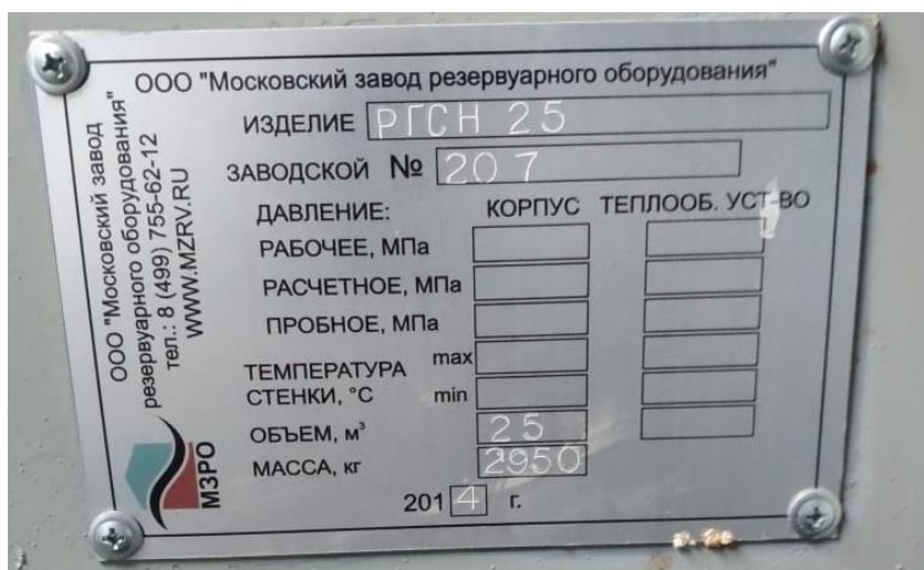
Рисунок 11 – Маркировочная табличка резервуара РГС-25, зав.№207
