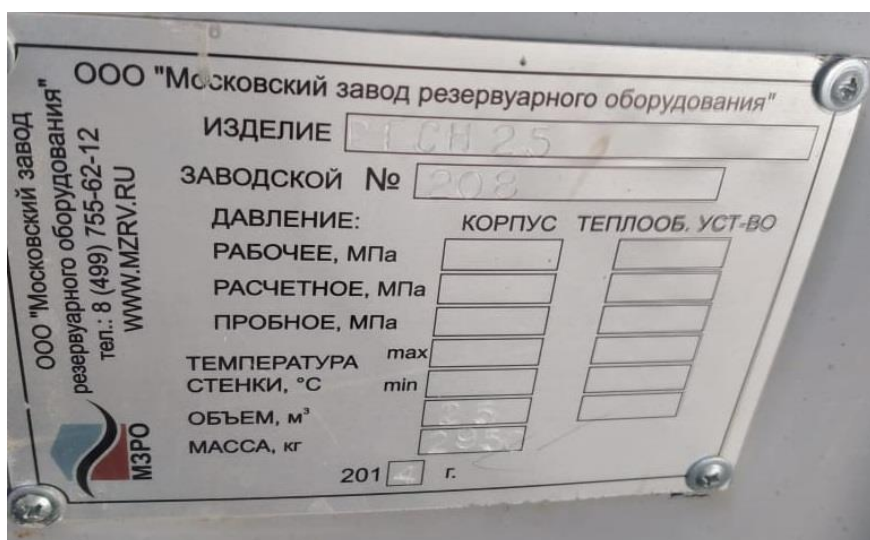
Рисунок 12 – Маркировочная табличка резервуара РГС-25, зав.№208
