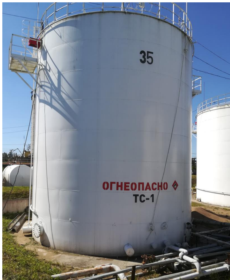
Рисунок 1 – Общий вид резервуара РВС-1000
