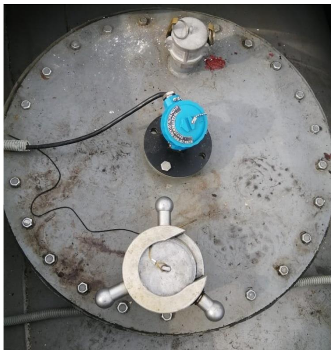
Рисунок 2 – Общий вид резервуаров РГС-25 зав.№№ 221, 222, 223, 224
