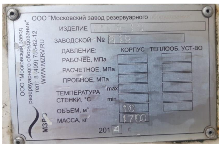
Рисунок 4 – Маркировочная табличка резервуара РГС-10, зав.№219
