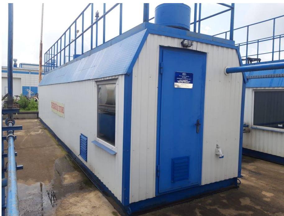
Рисунок 7 – Общий вид резервуаров РГС-25 зав.№№ 205, 206, 207, 208, 209
