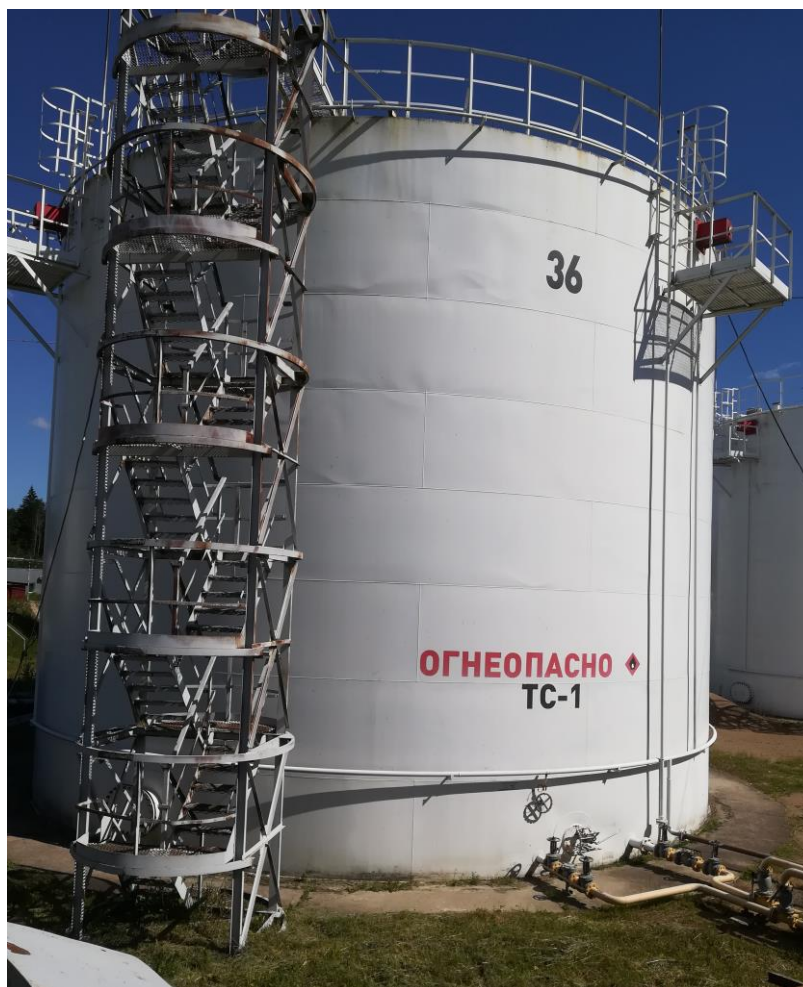
Рисунок 1 – Общий вид резервуара РВС-2000
