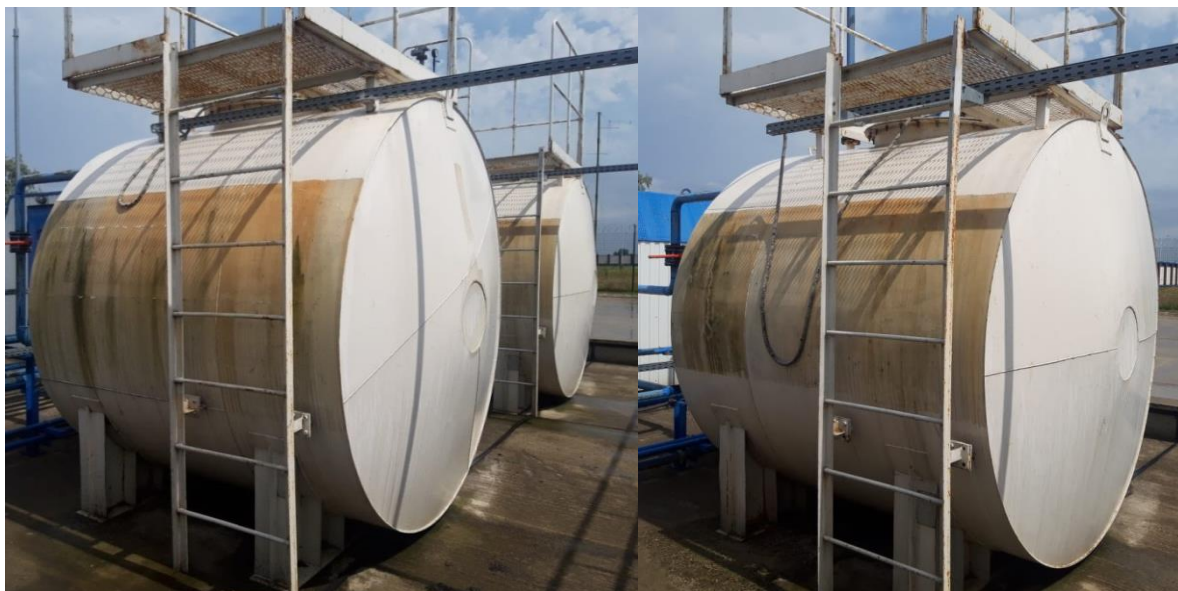
Рисунок 1 – Общий вид резервуаров РГС-10
