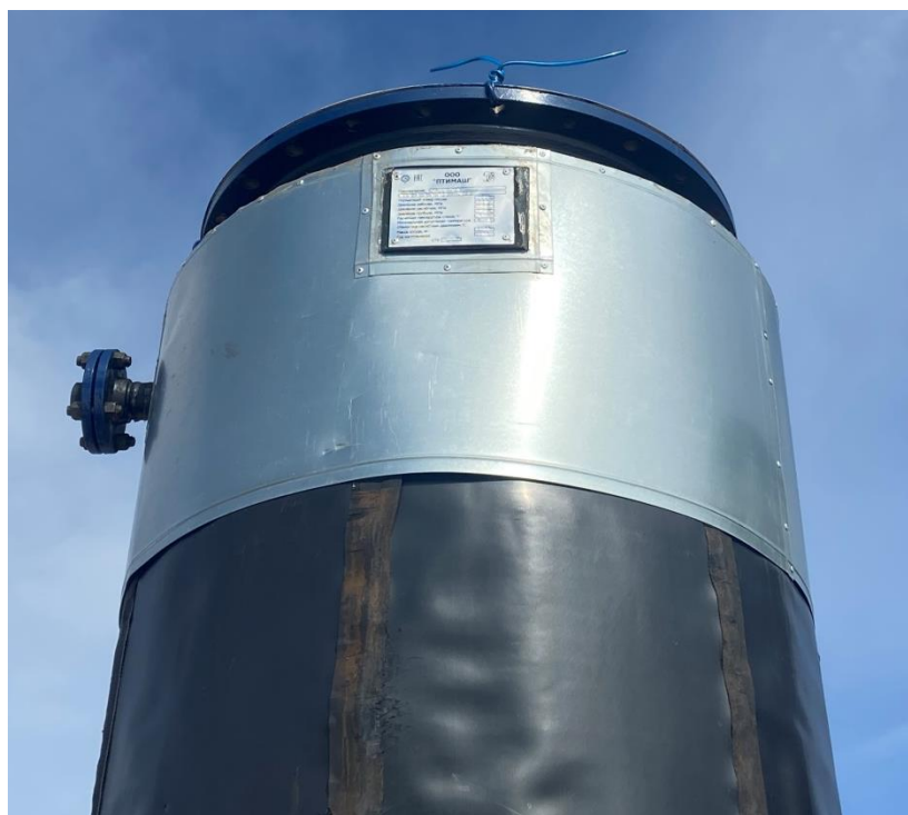
Рисунок 2 – Горловина резервуара стального горизонтального цилиндрического РГС-12,5
