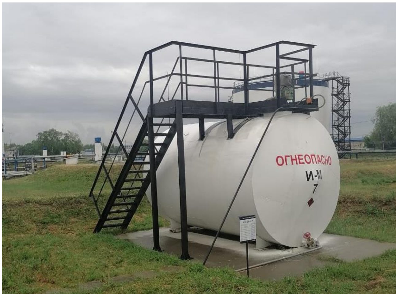
Рисунок 1 – Общий вид резервуара РГС-25
