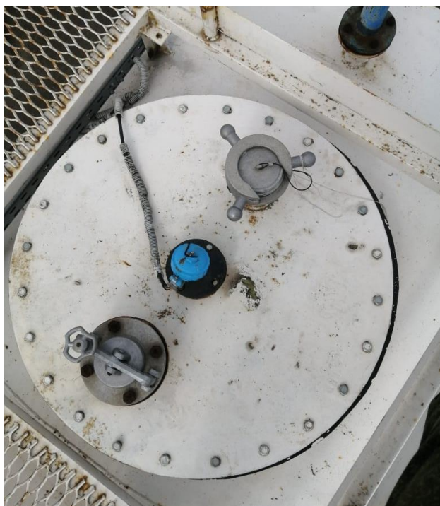
Рисунок 2 – Общий вид резервуаров РГС-10
