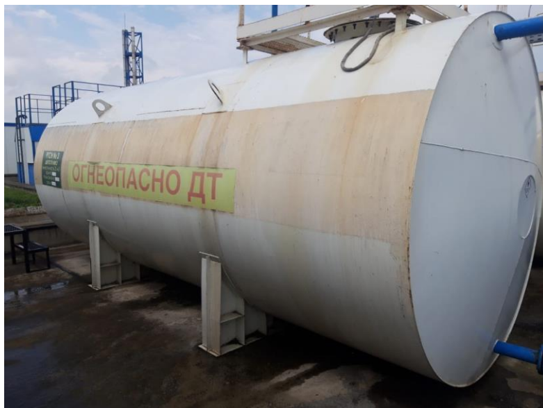
Рисунок 1 – Общий вид резервуаров РГС-25 зав.№№ 221, 222, 223, 224
