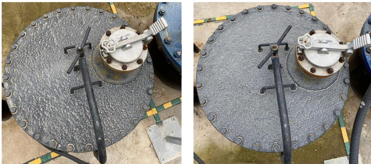
Рисунок 2 – Измерительные люки резервуаров РГС-5
