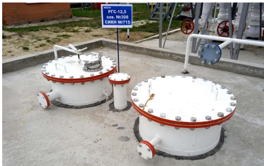
Рисунок 1 – Общий вид резервуара РГС-12,5 зав.№ 308
