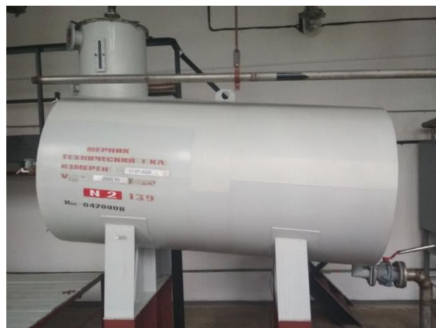
Рисунок 1 - Общий вид мерников технических 1-го класса М1кл-2500Н, зав.№№ 1, 2
