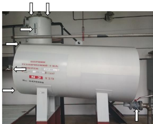
Рисунок 2 – Схема пломбировки мерников технических 1-го класса М1кл-2500Н, зав.№№ 1, 2 от несанкционированного доступа, обозначение места нанесения знака поверки
