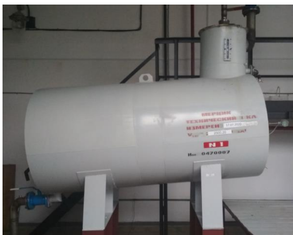
Рисунок 1 - Общий вид мерников технических 1-го класса М1кл-2500Н, зав.№№ 1, 2
