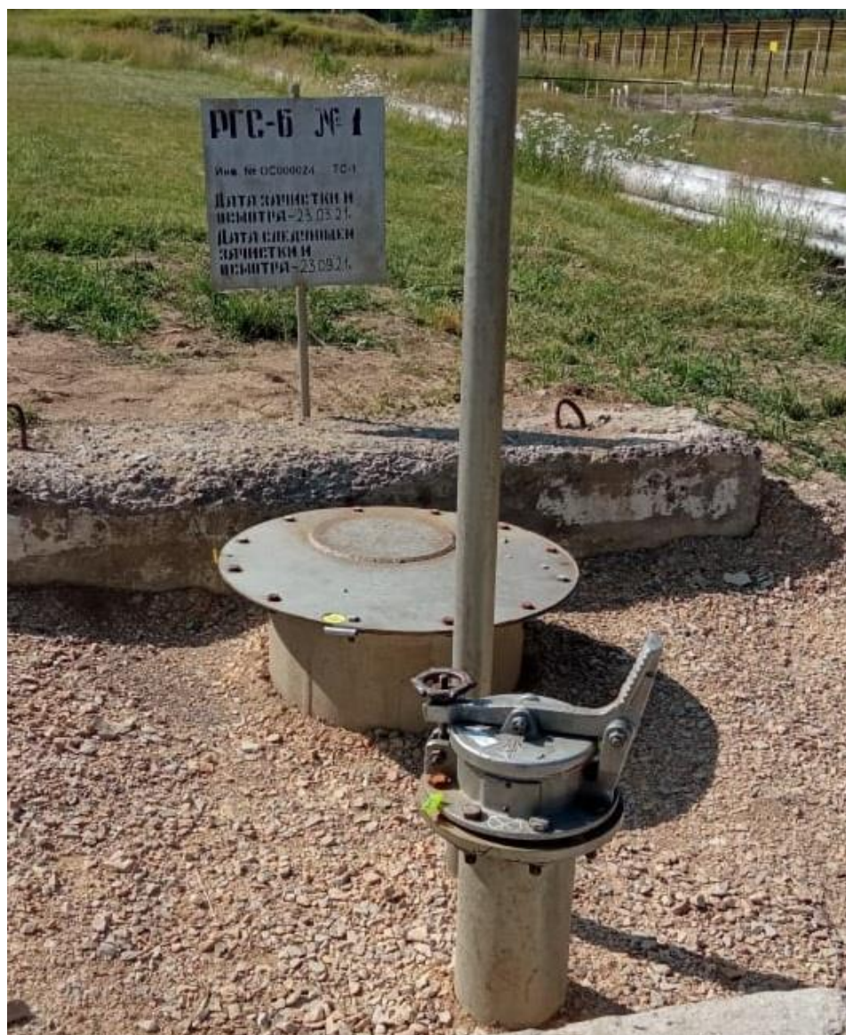
Рисунок 1 – Общий вид резервуара РГС-6
