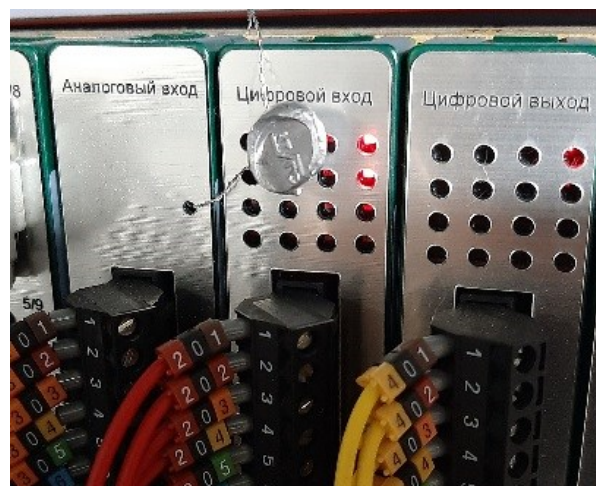
Рисунок 4 – Пломбирование платы аналогового входа контроллера
