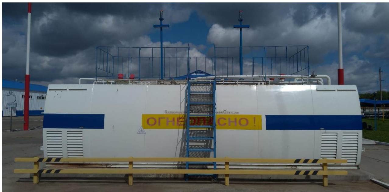
Рисунок 1 – Общий вид резервуаров РГС-16
