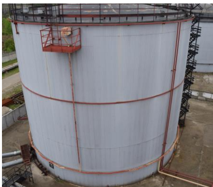
Рисунок 1 – Общий вид резервуаров
