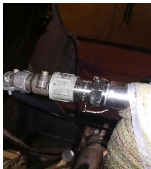
Рисунок 14 – Термосопротивление ТП-9201. Монтаж по месту
