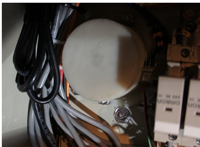
Рисунок 11 – Пломбирование преобразователя температуры PR
