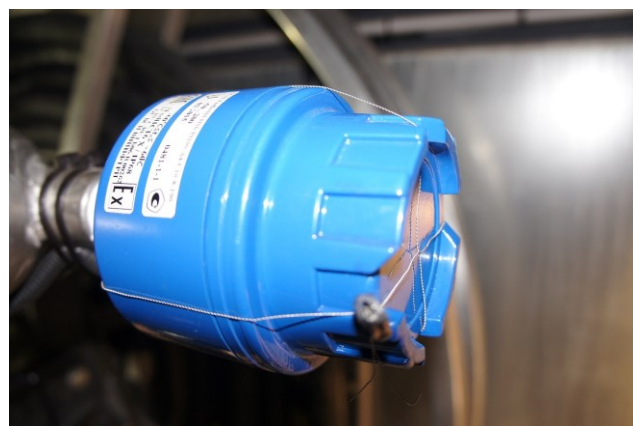
Рисунок 10 – Пломбирование датчика температуры
