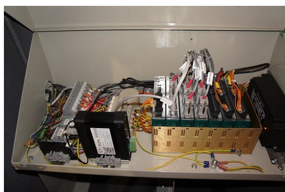
Рисунок 4 – БСК-01 без защитной крышки
