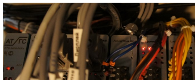
Рисунок 8 – Пломбирование платы аналогового входа контроллера
