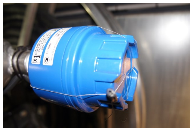
Рисунок 10 – Пломбирование датчика температуры
