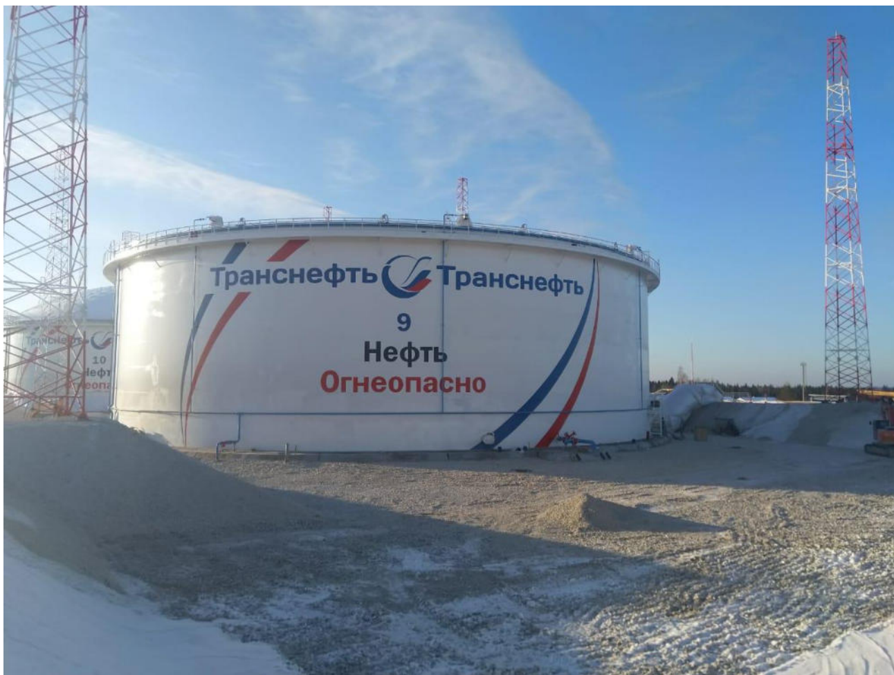
Рисунок 1 – Общий вид резервуара РВСПК-50000
