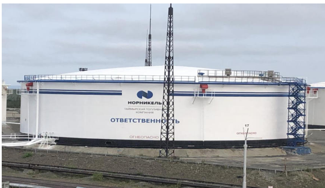
Рисунок 1. Общий вид резервуаров РВС-1000, РВС-5000, РВС-20000
