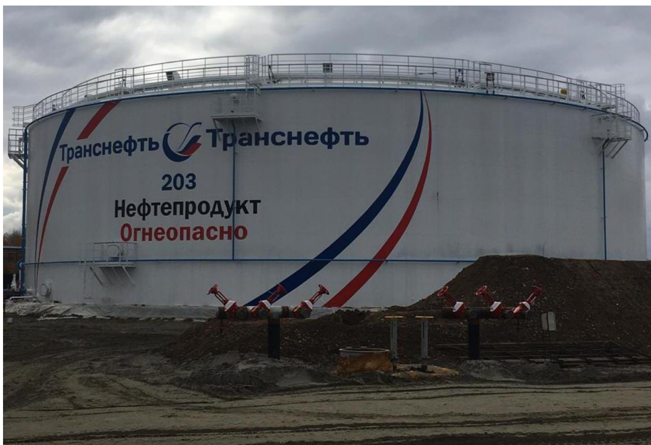
Рисунок 2 – Общий вид резервуаров РВСП-20000
