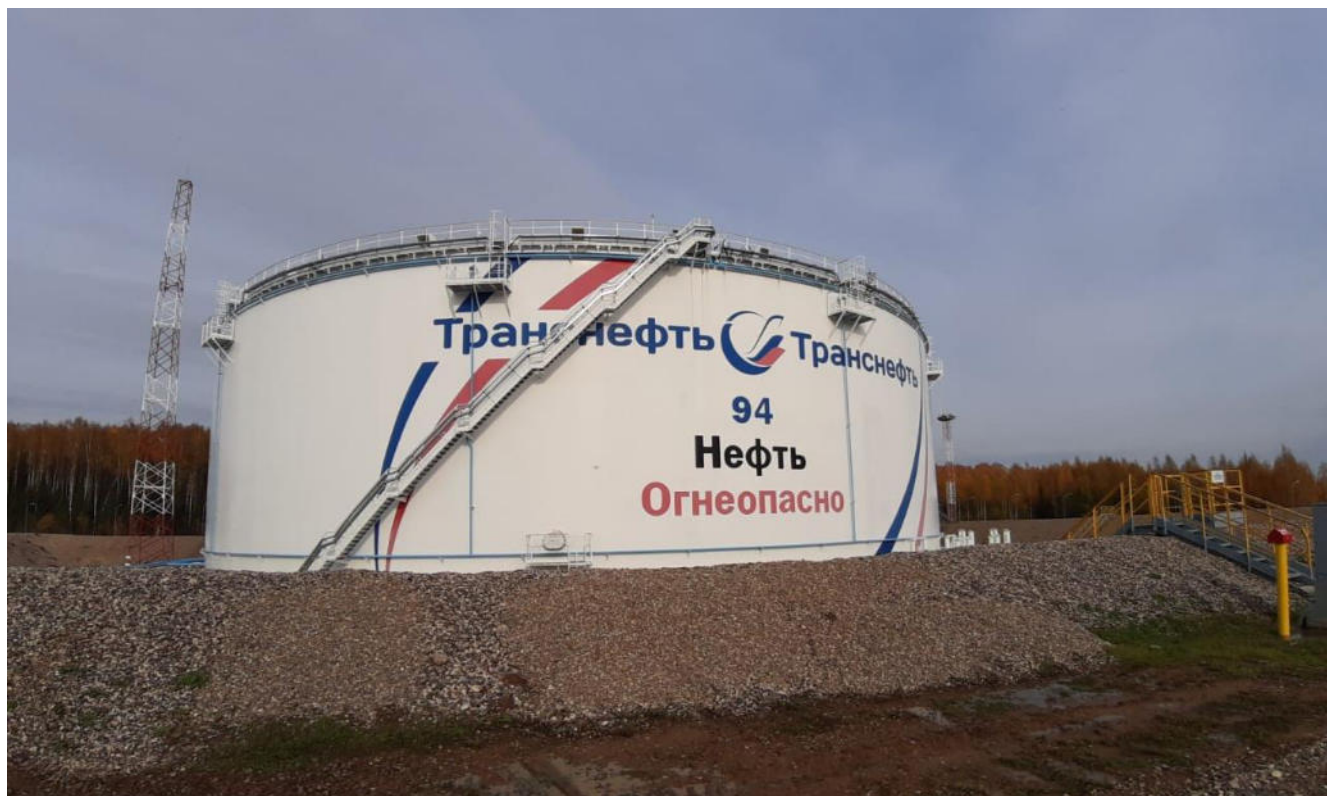
Рисунок 3 – Общий вид резервуара РВСП-50000
