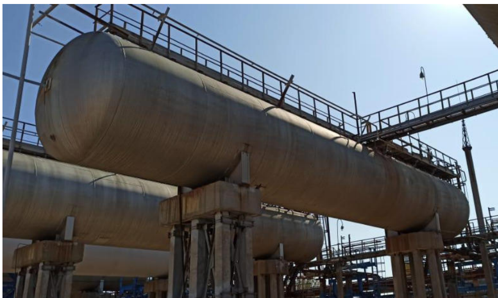
Рисунок 1 – Общий вид резервуаров РГС-200 зав.№ 8073, 8189, 8277, 8259, 8266, 8316, 8317, 8346, 8349, 8385, 8386
