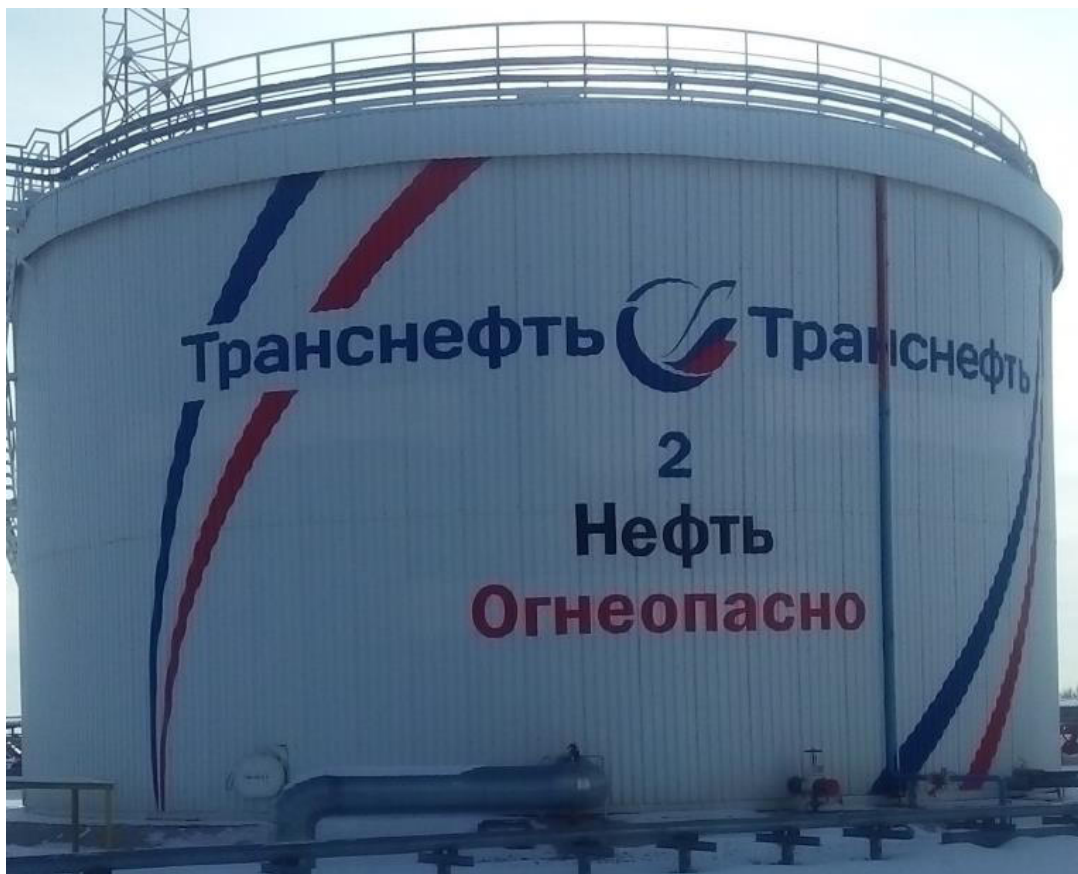
Рисунок 1 – Общий вид резервуаров РВС-5000
