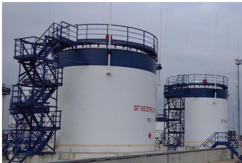
Рисунок 1 – Общий вид резервуаров РВС-429 зав. № 23067/0,429, 23068/0,429
