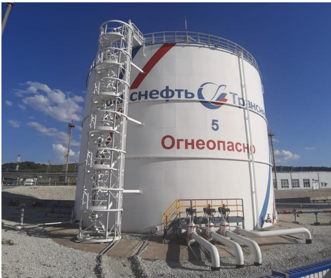
Рисунок 1 – Общий вид резервуаров РВС-5000
