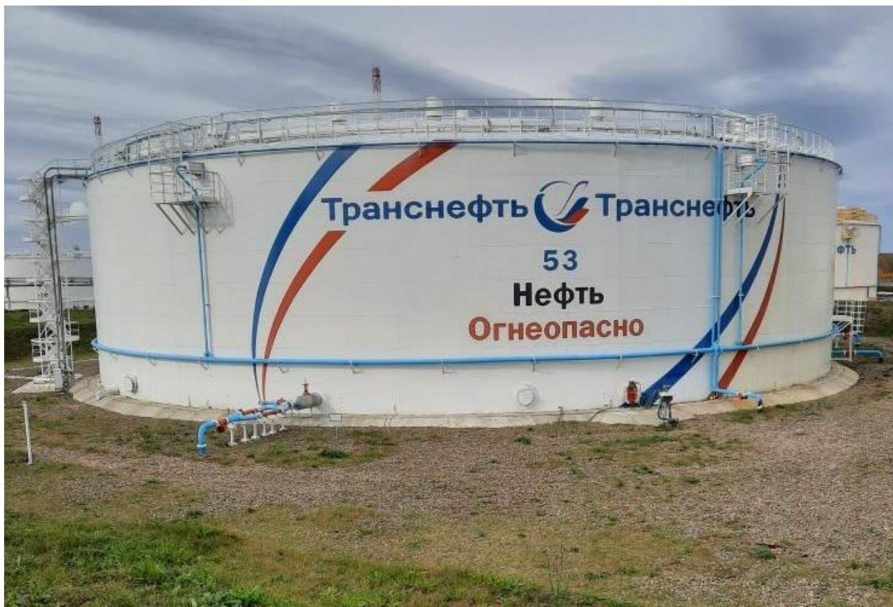
Рисунок 1 – Общий вид резервуара РВСП-20000
