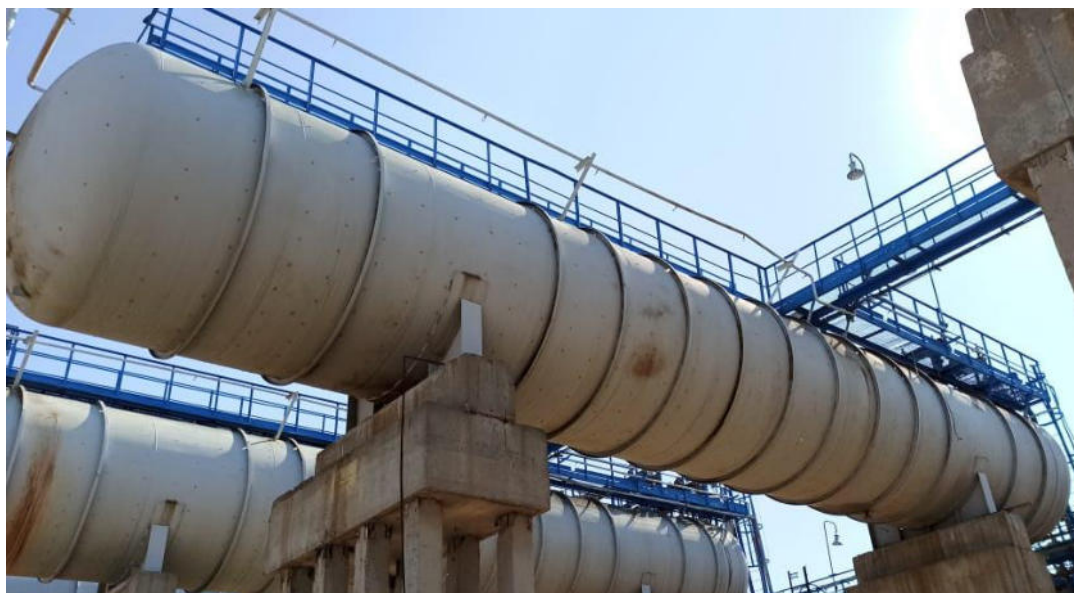
Рисунок 1 – Общий вид резервуаров РГС-200 зав.№ 315, 725, 926
