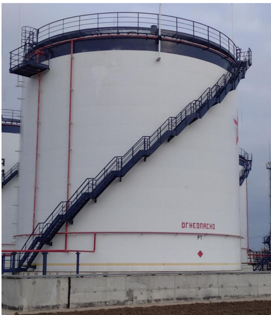
Рисунок 3 – Общий вид резервуаров РВС-4880 зав.№№ 23058/4,88, 23059/4,88, 23060/4,88, 23061/4,88
