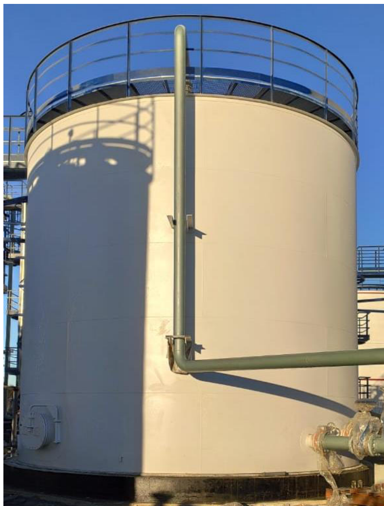
Рисунок 1 – Общий вид резервуаров РВС-400
