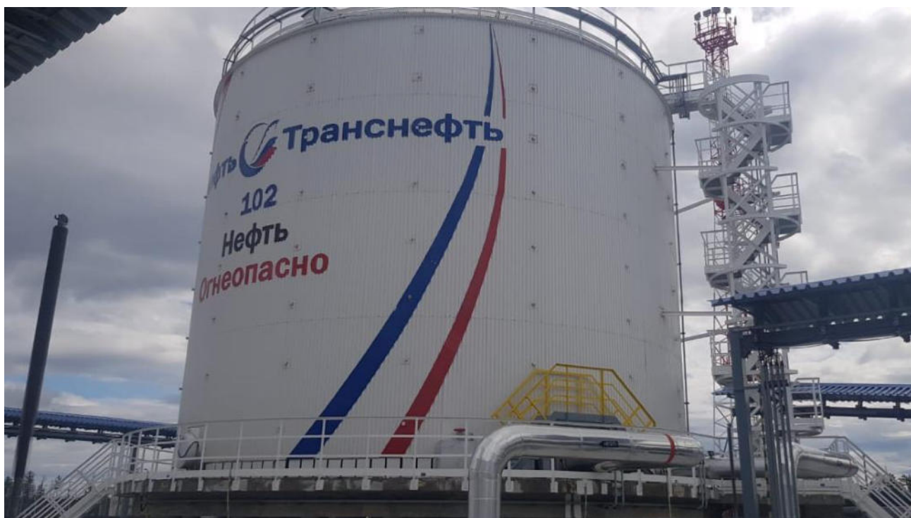
Рисунок 1 – Общий вид резервуаров РВС-2000
