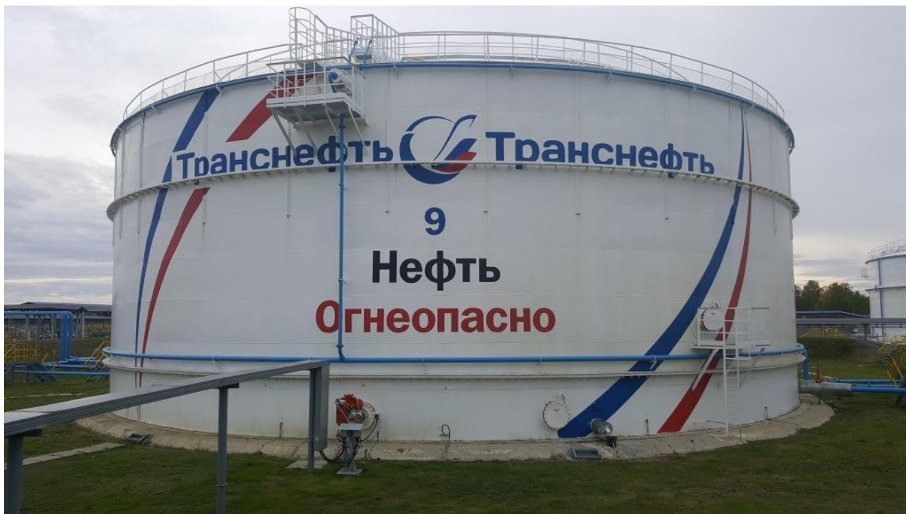
Рисунок 1 – Общий вид резервуара РВСП-10000
