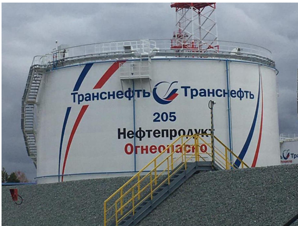
Рисунок 1 – Общий вид резервуаров РВСП-5000
