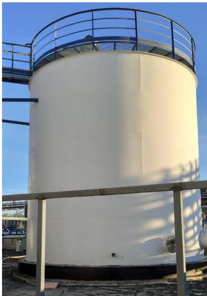
Рисунок 1 – Общий вид резервуаров РВС-300
