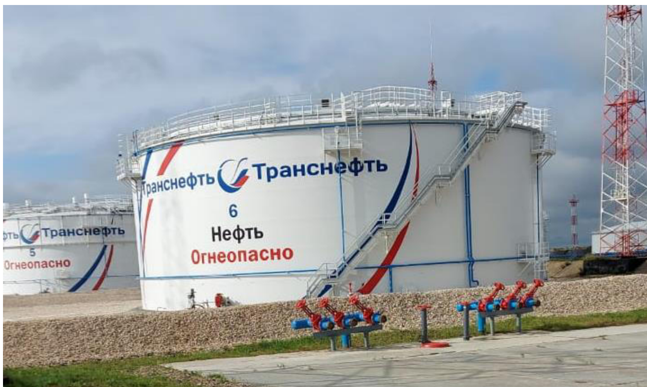
Рисунок 1 – Общий вид резервуара РВСП-10000
