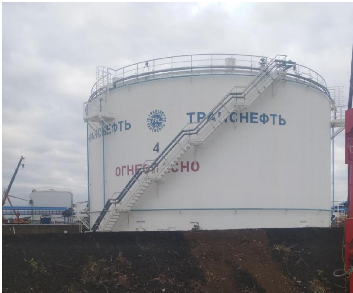
Рисунок 1 – Общий вид резервуара РВСП-5000
