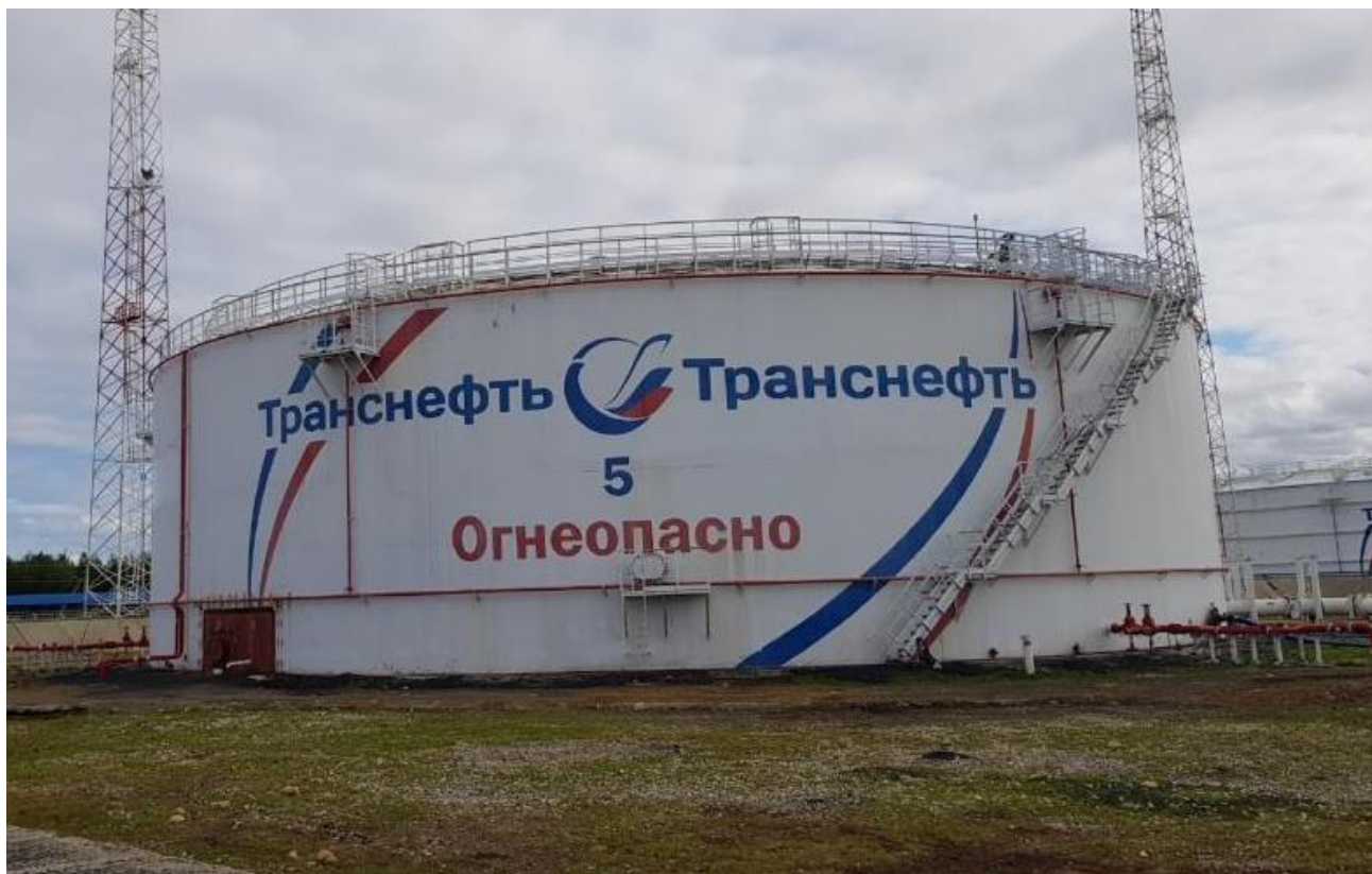
Рисунок 1 – Общий вид резервуара РВСП-20000
