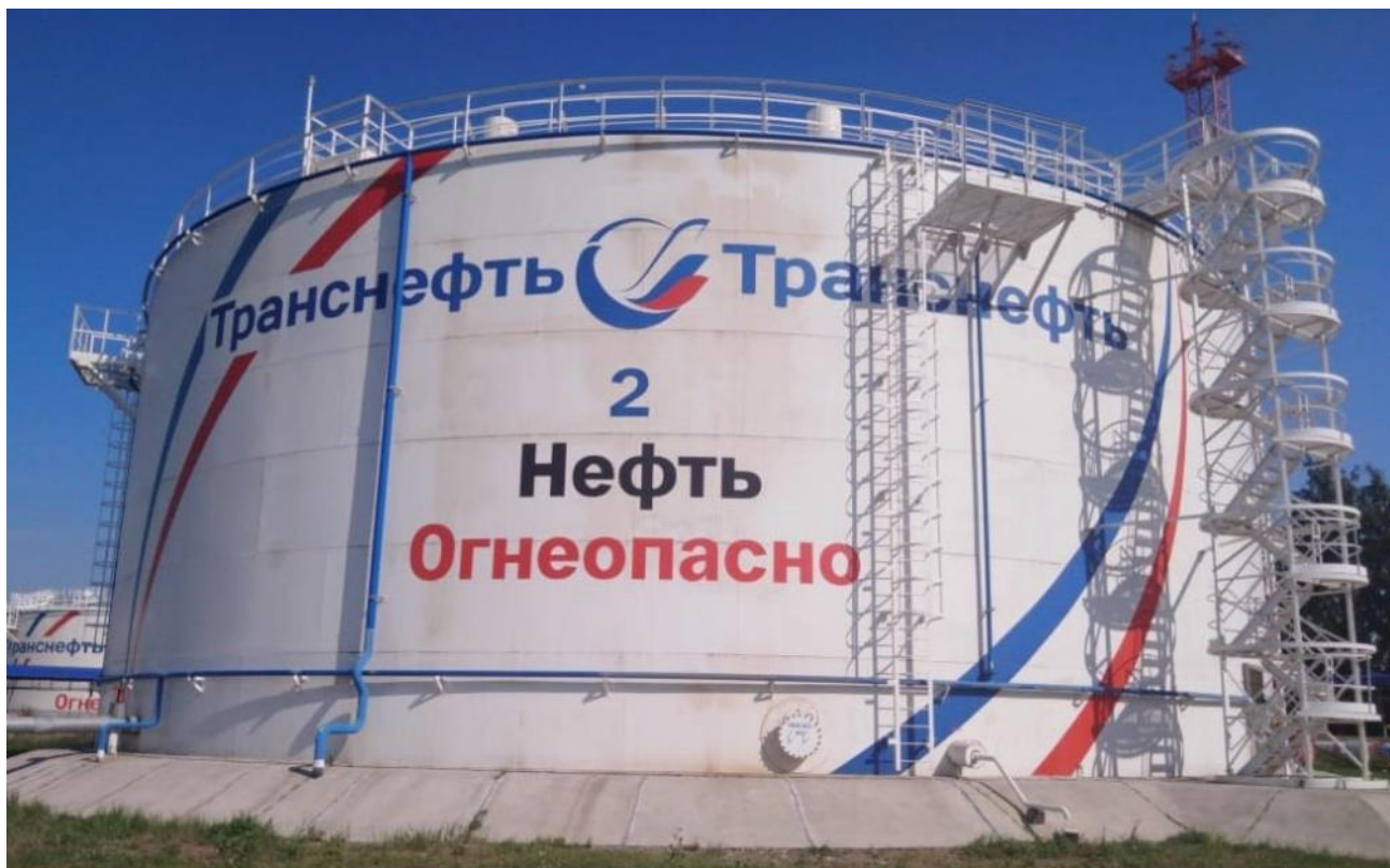
Рисунок 1 – Общий вид резервуара РВСП-10000
