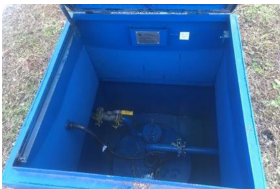
Рисунок 1 – Общий вид резервуара РГС-10 зав.№ 4529
