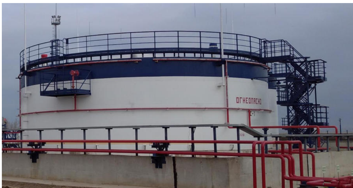
Рисунок 2 – Общий вид резервуаров РВС-1698 зав. № 23064/1,698, 23065/1,698, 23066/1,698
