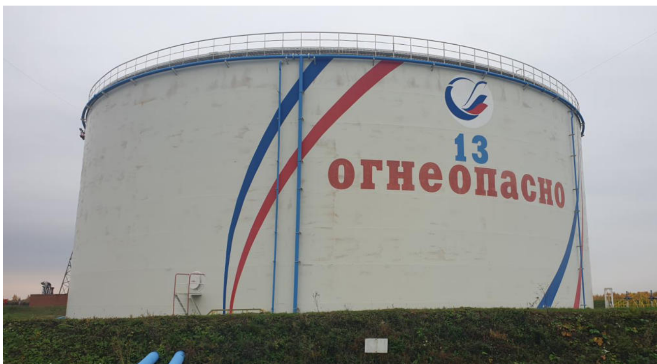
Рисунок 2 – Общий вид резервуаров РВСП-30000
