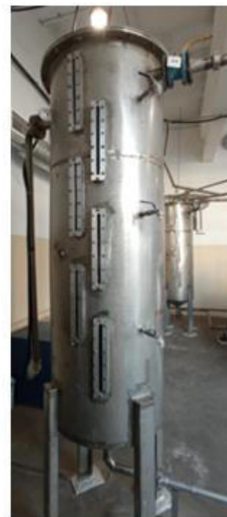
Рисунок 1 - Общий вид мерников МТ-ВИЦ-75Н, зав.№№ 18-81, 18-82
