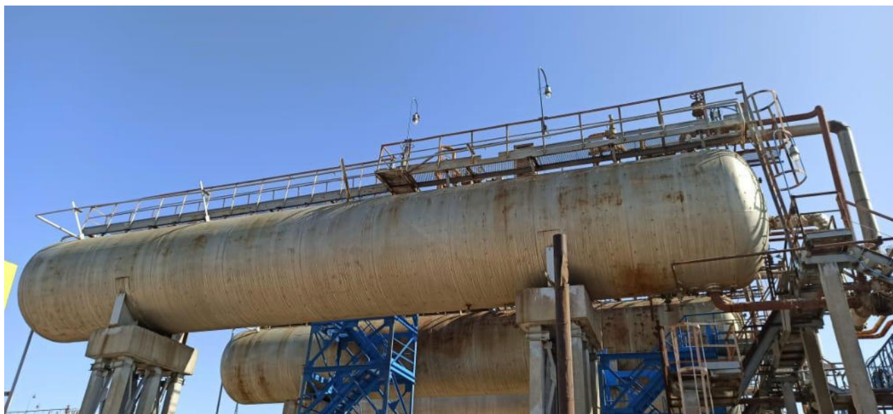
Рисунок 1 – Общий вид резервуаров РГС-200 зав.№ 1810, 2812, 2813
