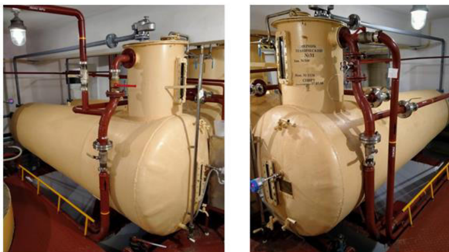
Рисунок 1 - Общий вид мерников 787-М, зав.№№ 499, 500
