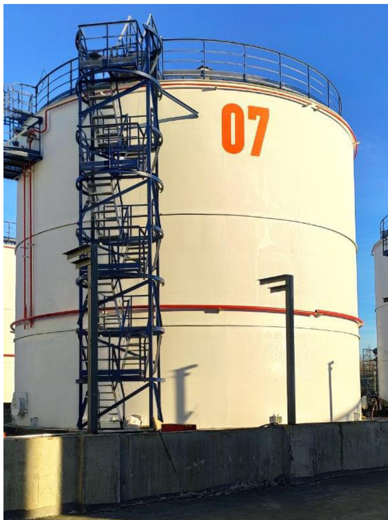
Рисунок 1 – Общий вид резервуаров РВС-2000
