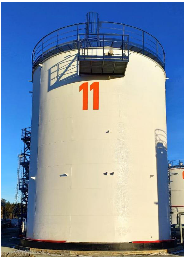
Рисунок 1 – Общий вид резервуаров РВС-1000
