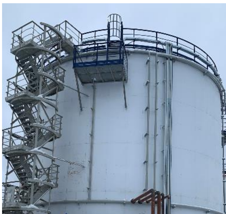
Рисунок 1 - Общий вид резервуара зав. № 6.8.1 с указанием места нанесения заводского номера, общий вид замерного люка
