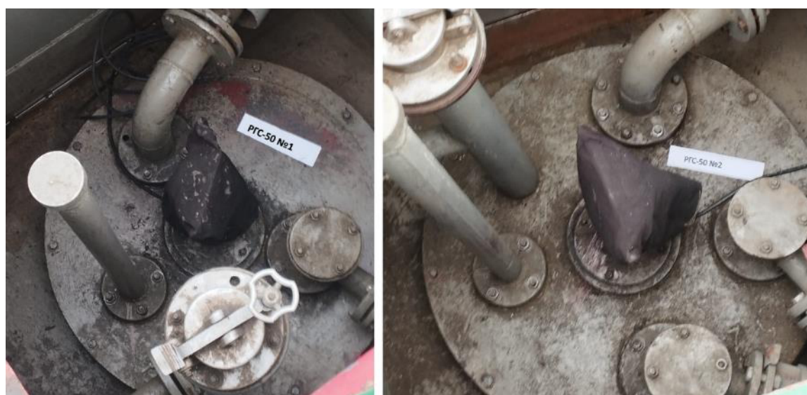
Рисунок 3 – Горловины резервуаров РГС-50 зав.№№ 1, 2
