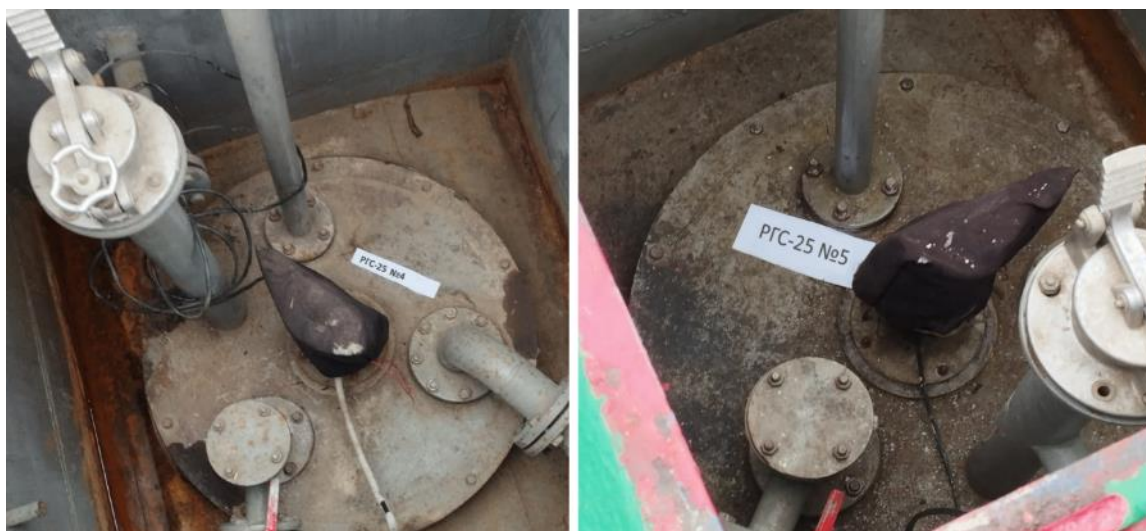
Рисунок 2 – Горловины резервуаров РГС-25 зав.№№ 4, 5
