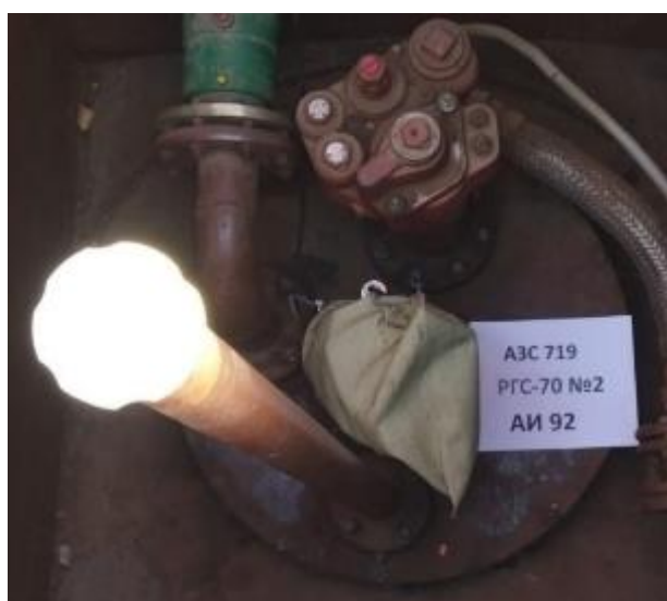
Рисунок 6 – Горловина резервуара РГС-70 зав.№ 2
