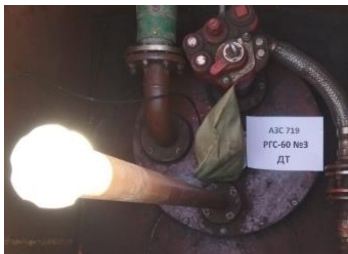
Рисунок 5 – Горловина резервуара РГС-60 зав.№ 3
