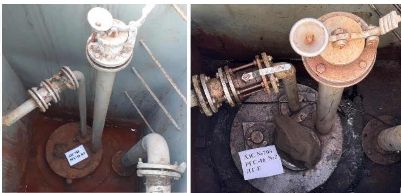
Рисунок 3 – Горловины резервуаров РГС-16 зав.№№ 1, 2
