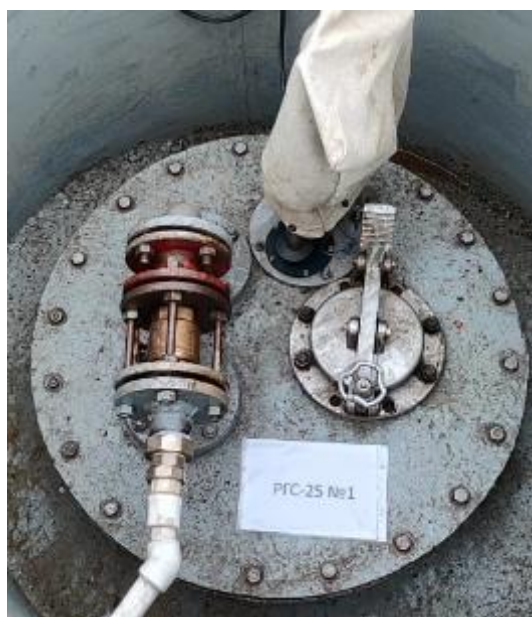
Рисунок 3 – Горловина резервуара РГС-25 зав.№ 1
