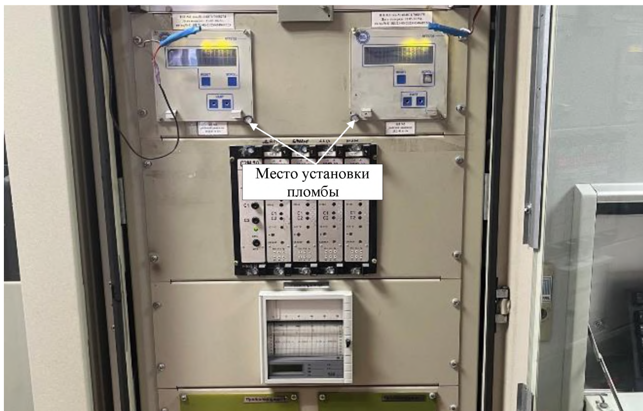
Рисунок 2 – Схема пломбирования вторичного измерительного преобразователя
