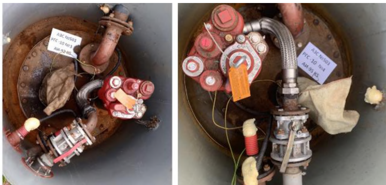
Рисунок 3 – Горловины резервуаров РГС-10 зав.№№ 3, 4
