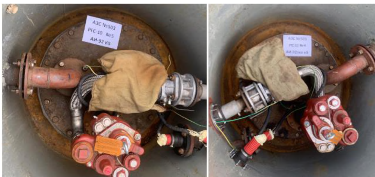
Рисунок 4 – Горловины резервуаров РГС-10 зав.№№ 5, 6
