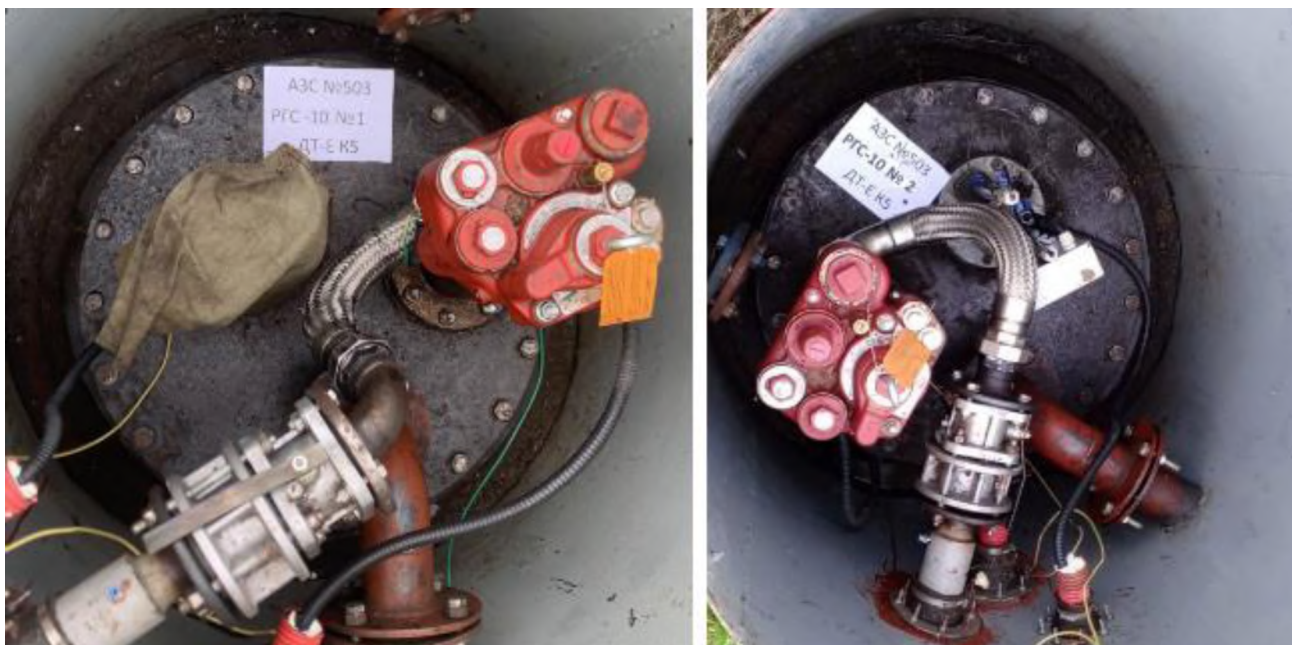
Рисунок 2 – Горловины резервуаров РГС-10 зав.№№ 1, 2
