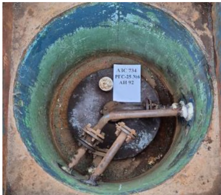
Рисунок 2 – Горловина резервуара РГС-25 зав.№ 6
