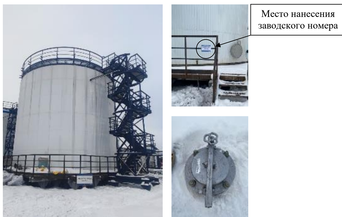
Р и с у н о к 2 – Общий вид резервуара зав. № 10056/07 с указанием места нанесения заводского номера, общий вид замерного люка
