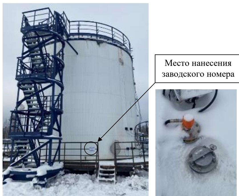
Р и с у н о к 1 – Общий вид резервуара зав. № 10055/07 с указанием места нанесения заводского номера, общий вид замерного люка
