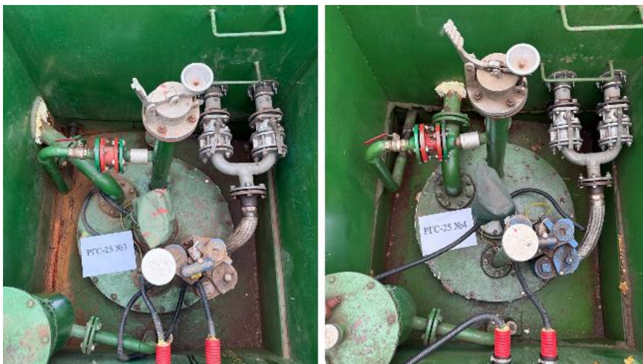
Рисунок 3 – Горловины резервуаров РГС-25 зав.№№ 3, 4
