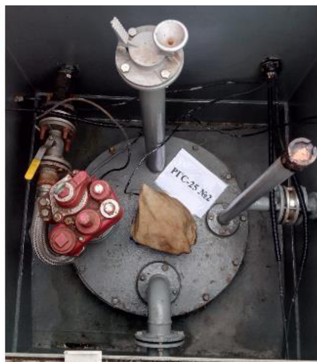
Рисунок 2 – Горловины резервуаров РГС-25 зав.№№ 1, 2
