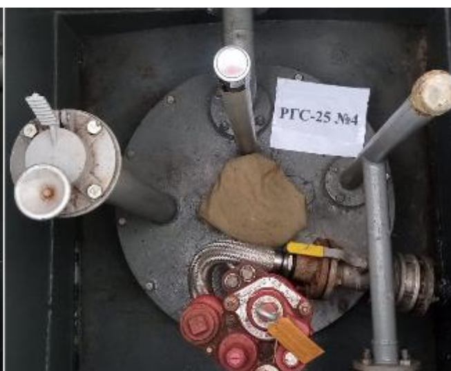
Рисунок 3 – Горловины резервуаров РГС-25 зав.№№ 3, 4
