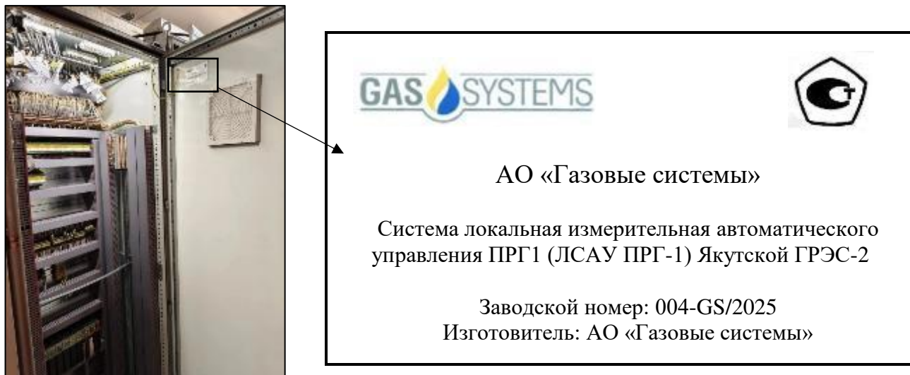
Рисунок 1 – Общий вид корпуса шкафа вторичной части ИК ИС с маркировочной табличкой
