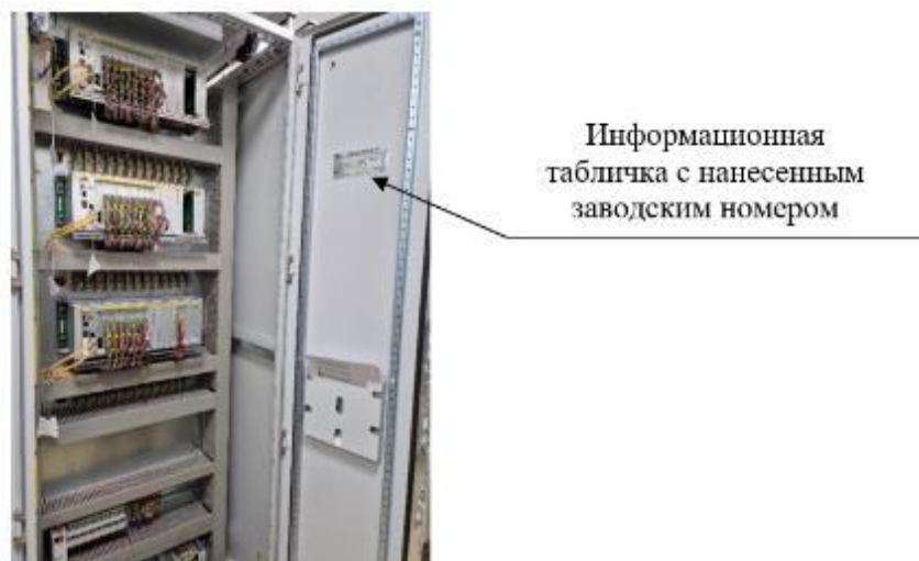
Рисунок 1 – Вид контроллерных шкафов «ИНКОНТ»
