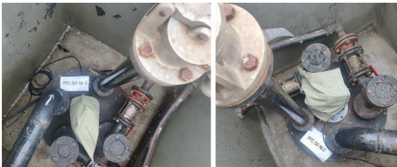
Рисунок 2 – Горловины резервуаров РГС-50 зав.№№ 1, 2
