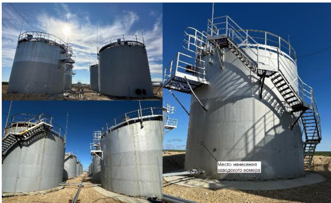
Рисунок 1 – Общий вид резервуаров вертикальных стальных цилиндрических РВС-400 зав.№ 2.1, 2.2, 2.3, 2.4, 2.5, 2.6, 2.7, 2.8, 2.9, 2.10, 2.11, 2.12, 2.14 с указанием места нанесения заводских номеров
