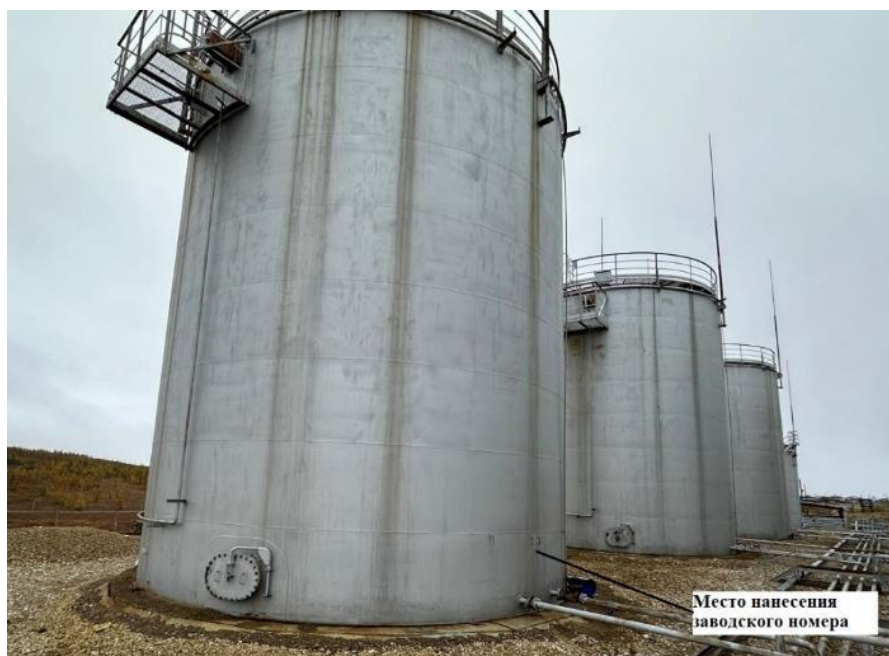
Рисунок 1 – Общий вид резервуаров вертикальных стальных цилиндрических РВС, РВС-1000 зав.№№ 1.1, 1.3, 1.5 с указанием места нанесения заводских номеров
