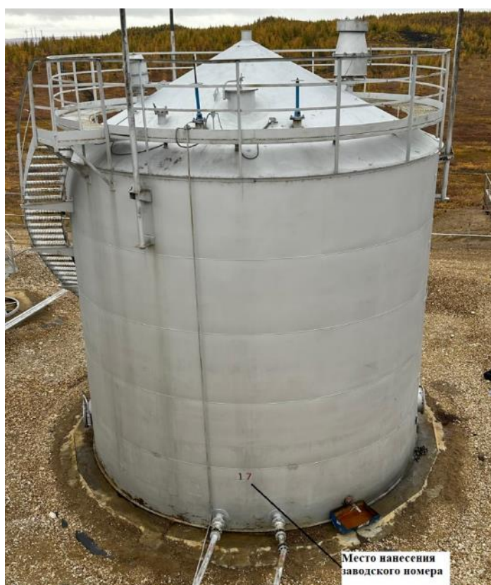
Рисунок 2 – Общий вид резервуара вертикального стального цилиндрического РВС, РВС-400 зав.№ 1.7 с указанием места нанесения заводских номеров
