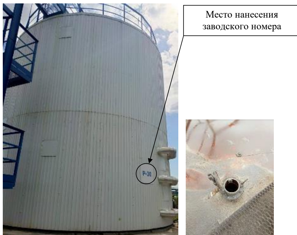
Р и с у н о к 1 – Общий вид резервуара с заводским номером Р-30 и его замерного люка
