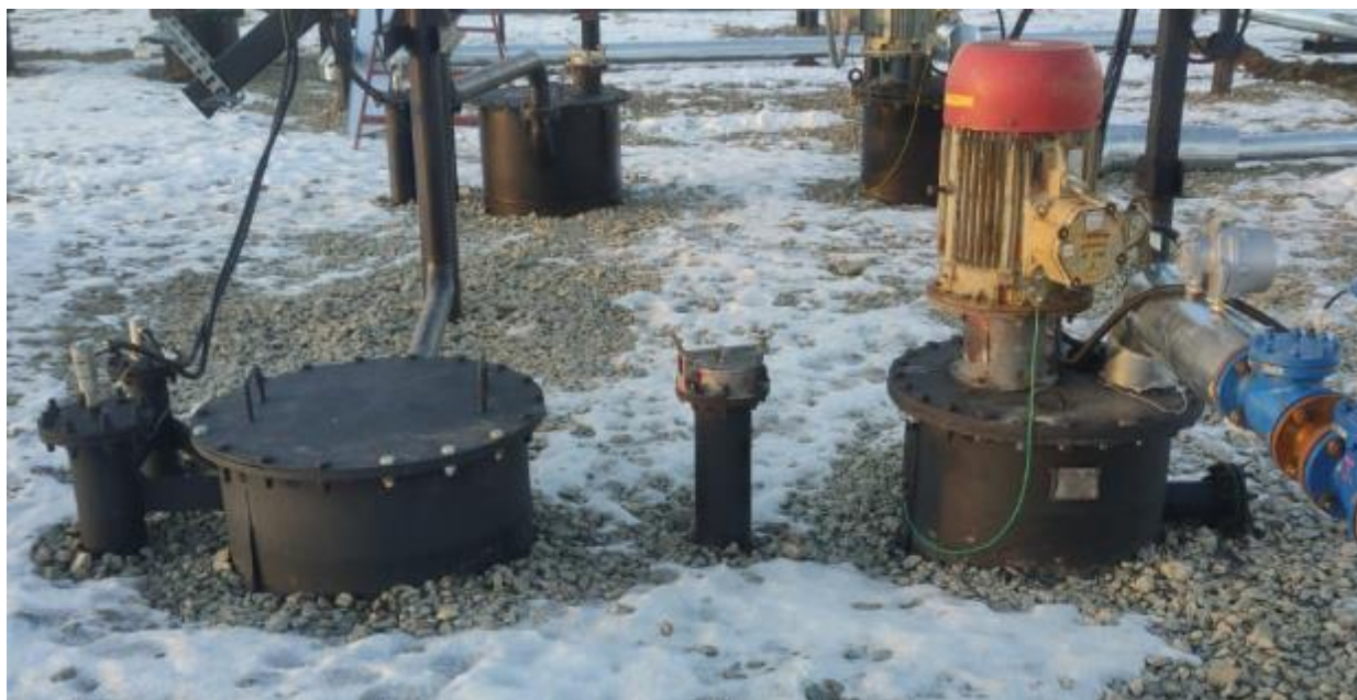
Рисунок 3 – Горловины и измерительный люк резервуара ЕП 12,5-2000-1300-1-3 с зав.№ 07
