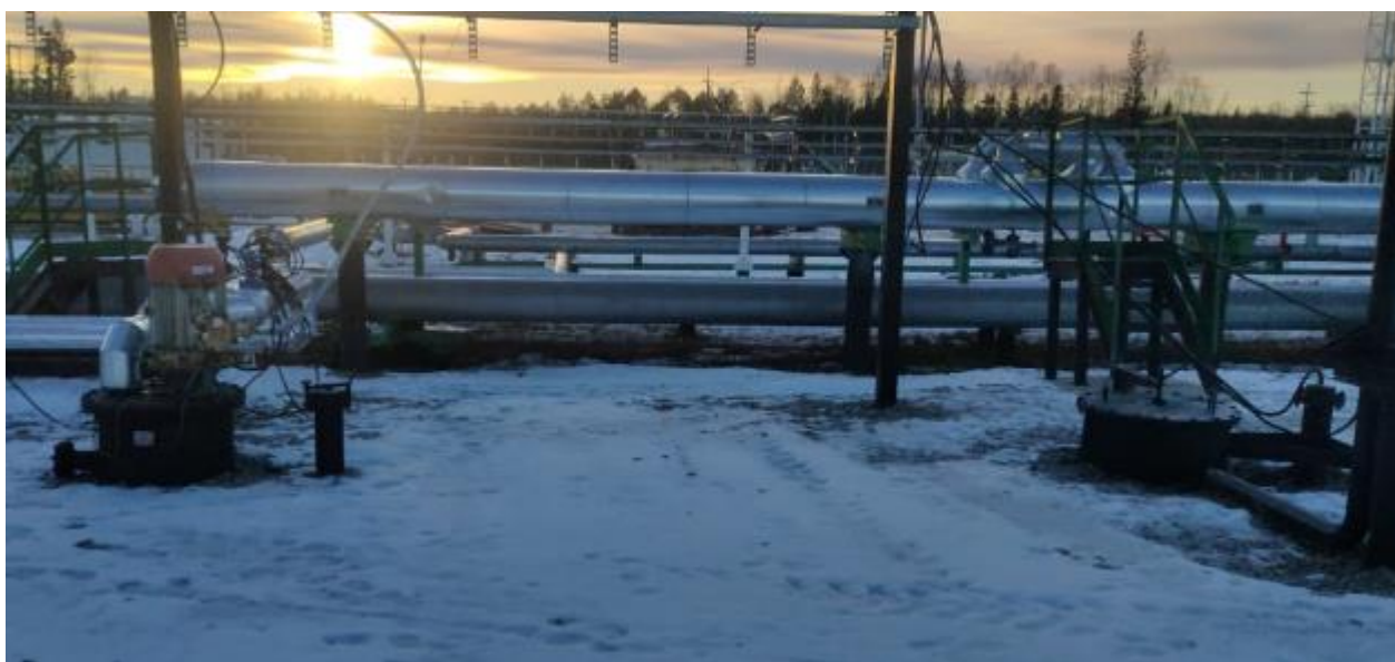
Рисунок 5 – Горловины и измерительный люк резервуара ЕП 63-3000-1800 с зав.№ 06
