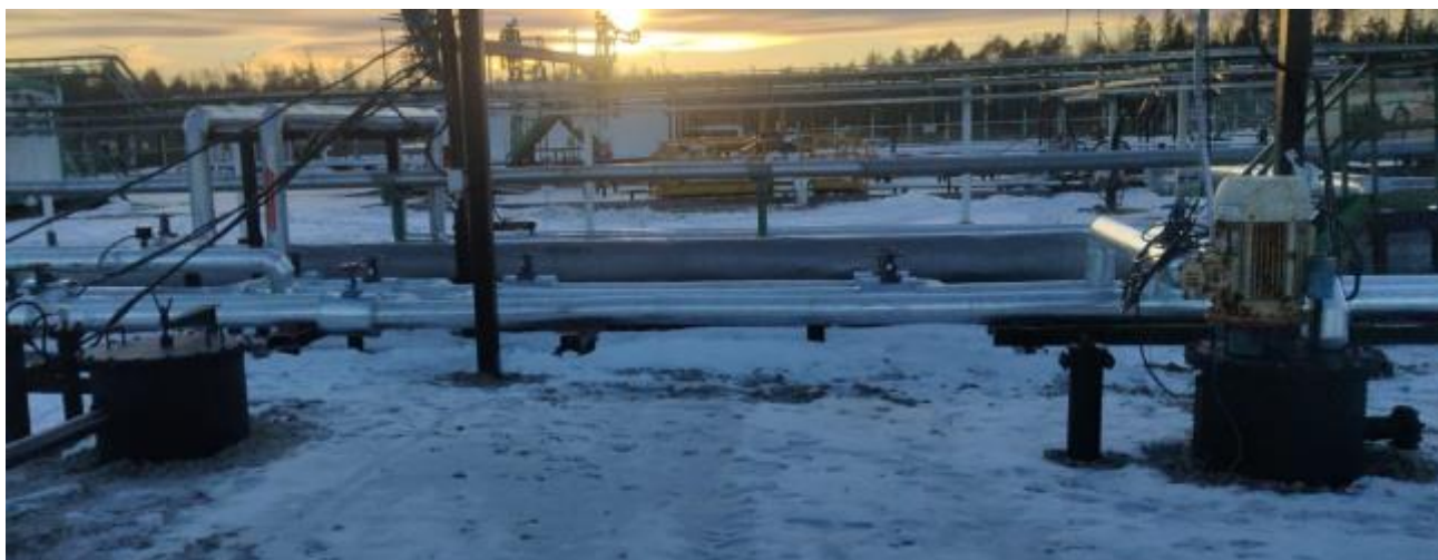
Рисунок 6 – Горловины и измерительный люк резервуара ЕП 63-3000-1800 с зав.№ 08
