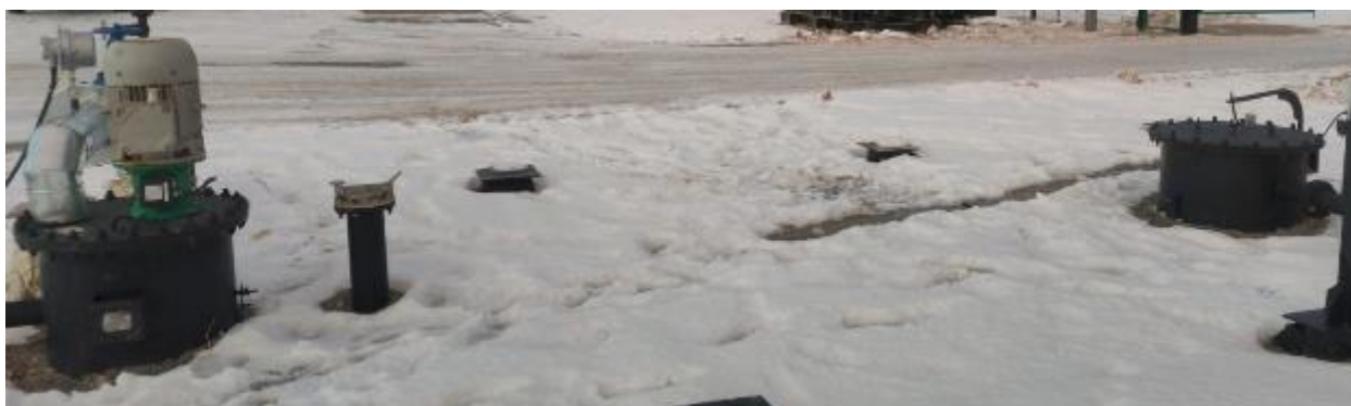
Рисунок 4 – Горловины и измерительный люк резервуара ЕП 63-3000-1000 с зав.№ 04
