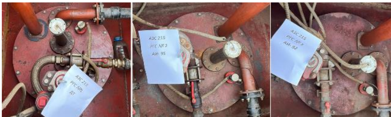
Рисунок 2 – Горловины резервуаров РГС-25 зав.№№ 1, 2, 3
