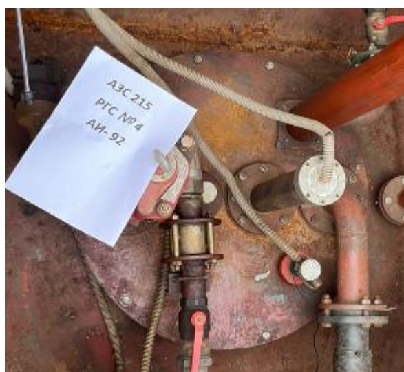
Рисунок 3 – Горловины резервуаров РГС-50 зав.№ 4
