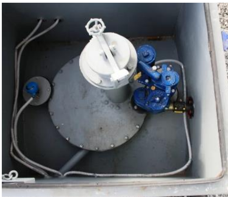
Р и с у н о к 4 – Фотографии горловин и замерных люков резервуаров
